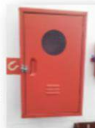
Instalação de caixas de incêndio
