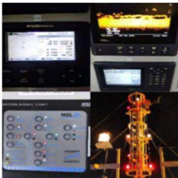
Figura 12 - Testes nos equipamentos do passadiço.
