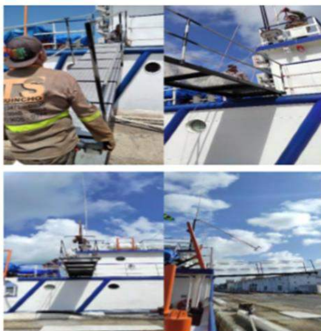
Figura S1 - Instalação da Rampa de acesso no CM IV.
