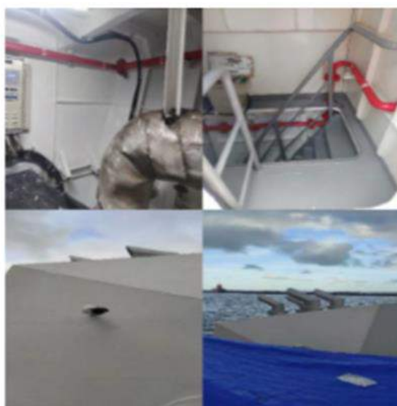
Figura 18 - Pintura da praça de máquinas e chaminé.
