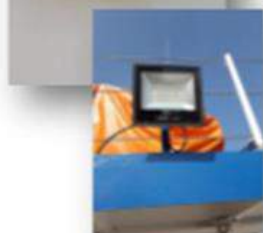
Instalação de quatro refletores em LED
