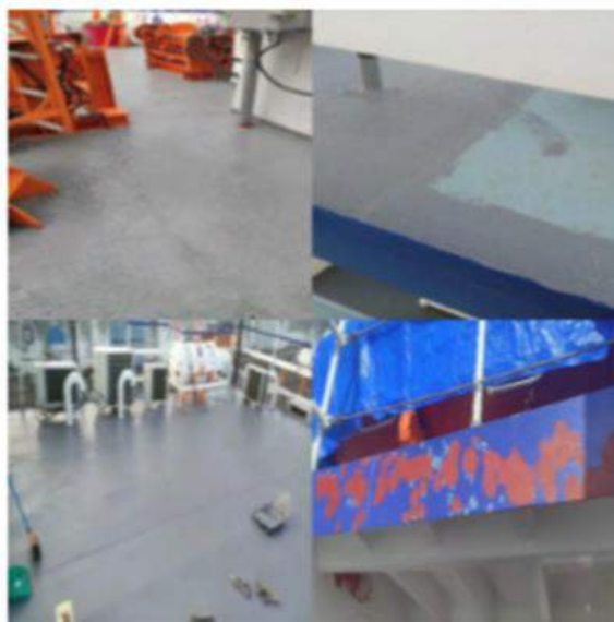
Figura 17 - Setores contemplados com pintura na cor padrão.
