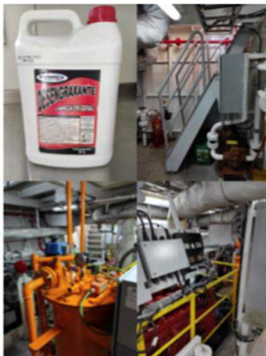
Figura 6 - Serviços de limpeza , na praça de máquinas.
