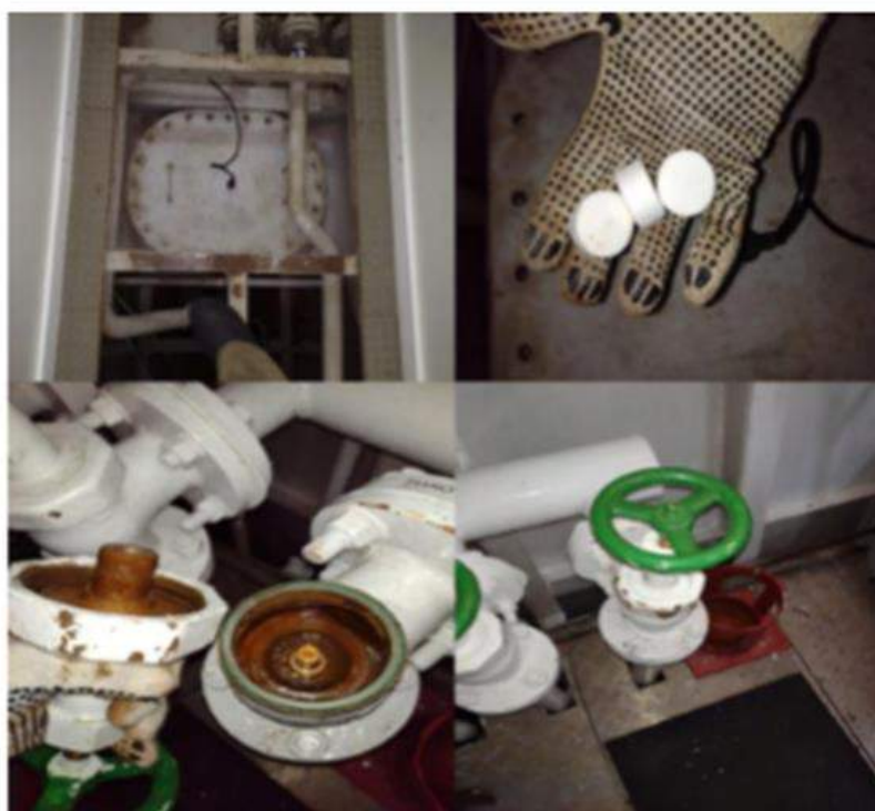
Figura 9 - Inspeção e manutenção das redes do navio.
