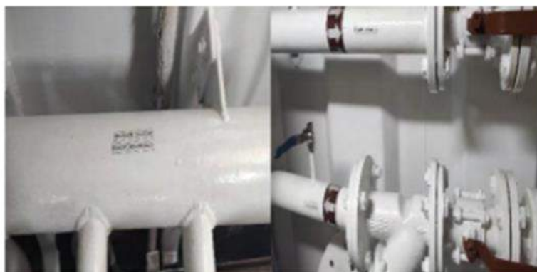
Figura 30 - Válvulas tratadas na praça de máquinas.
