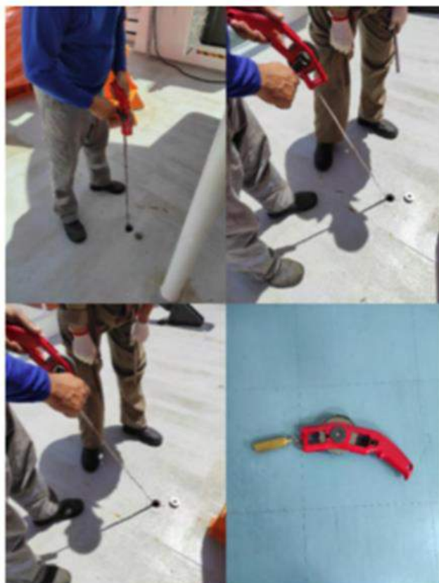
Figura 10 - Medição do existente óleo combustível.
