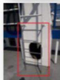
Confecção de prolongamento da escada
