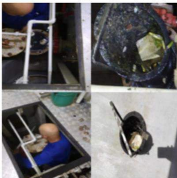
Figura 8 - Abertura e limpeza da caixa de mar.
