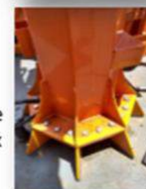
Troca de todos os parafusos de fixação para aço inox
