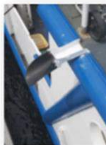
Instalação de saídas de água do piso (bicos de pato)
