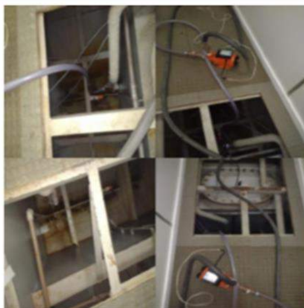
Figura 29 - Imagens do procedimento de limpeza nas dalas.
