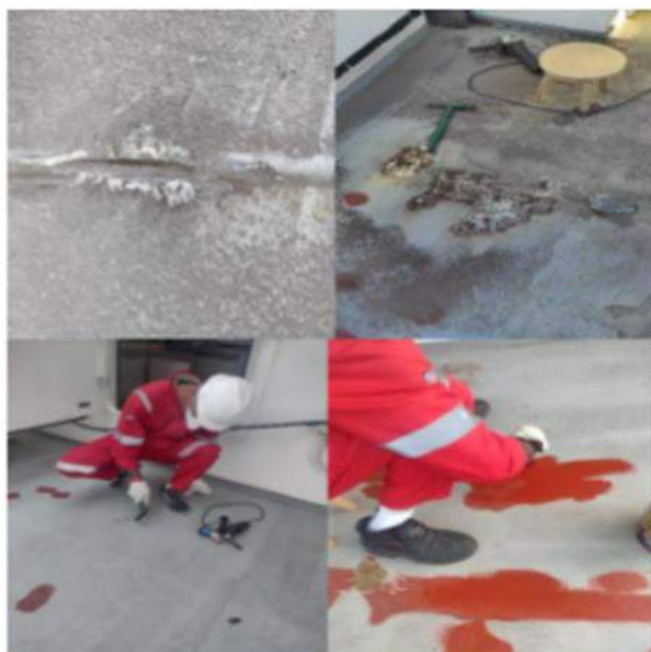
Figura 16 - Tratamento de pintura realizado no convés principal.
