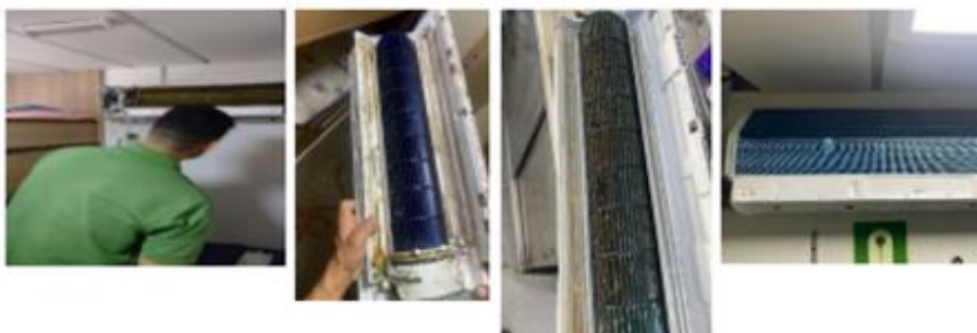
Figura 13 - Fotos do serviço de manutenção e reparo dos aparelhos de ar condicionado
