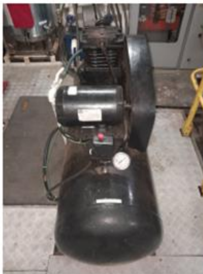
Figura 18. Serviço executado no compressor da embarcação.
