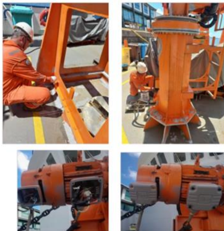
Figura 5. Manutenção nas estruturas do guinchos e molinetes.
