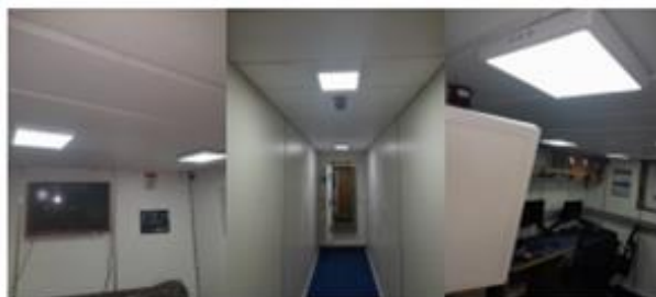
Figura 30. Exemplo de serviço de troca de luminárias.
