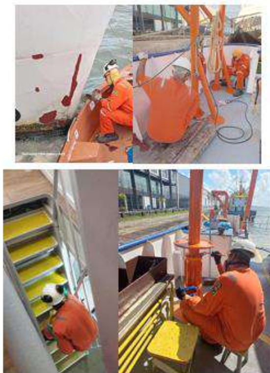
Figura 3. Tratamento de pintura na área externa da embarcação .
