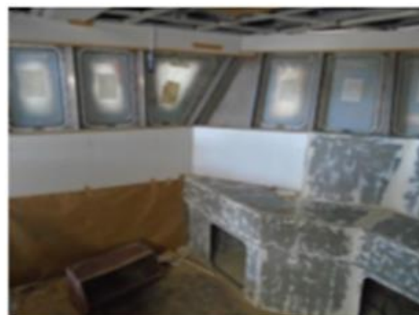
Foto nº 47 – Revestimento e janelas do passadiço
