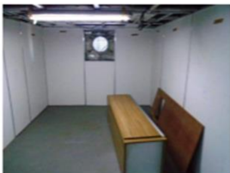
Foto nº 44 – Revestimento sala acústica
