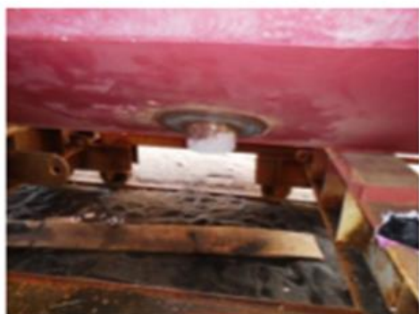
Foto nº 7 – Base para instalação da PI50
