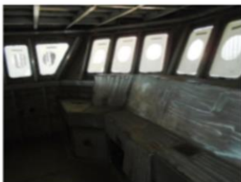
Foto nº 35 – Janelas no passadiço
