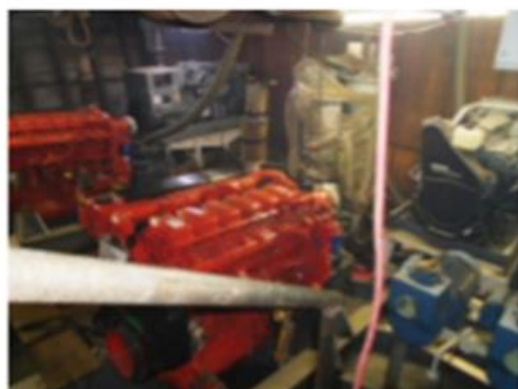
Foto nº 39 – Vista da praça de máquinas
