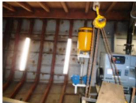
Foto nº 29 – Tanque hidrofor reposicionado
