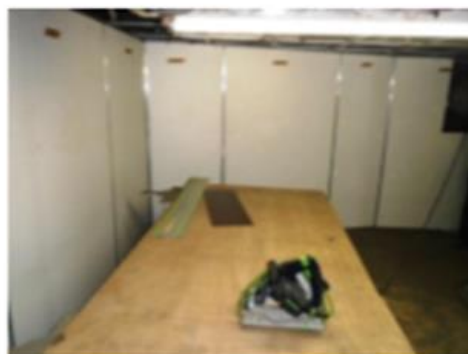
Foto nº 43 – Início acabamento refeitório
