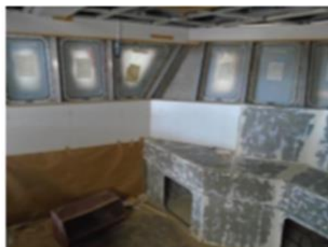
Foto nº 47 – Revestimento e janelas do passadiço
