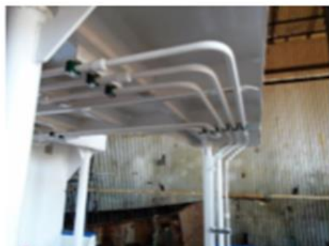
Foto nº 15 – Tubulações hidráulicas
