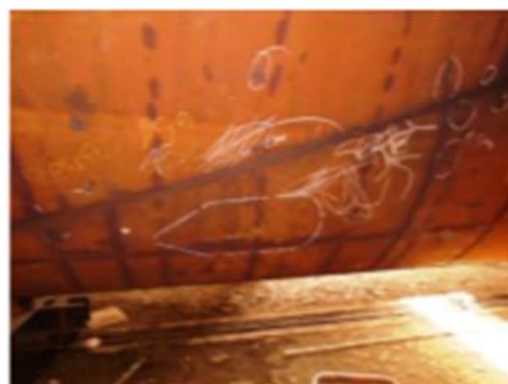
Foto nº 13 – Marcação para o domo
