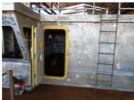
Foto nº 62 – Porta da antepara de ré
