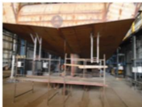
Foto nº 65 – Preparação para abertura para passagem dos eixos propulsores casco 656
