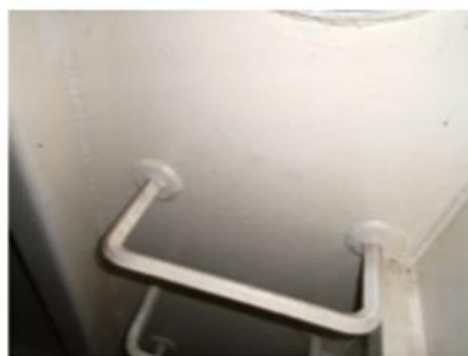
Foto nº 22 – Escada interna de tanque
