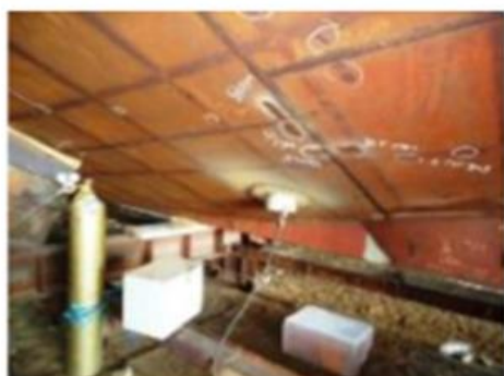
Foto nº 30 – Limpeza e reparos em soldas 654
