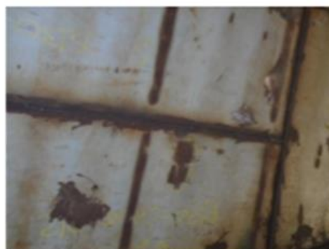
Foto nº 36 – Cordão de solda a ser reparado
