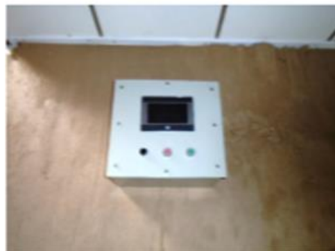
Foto nº 17 – Medidor de cabo lançado
