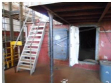
Foto nº 34 – Escadas de acesso e portas
