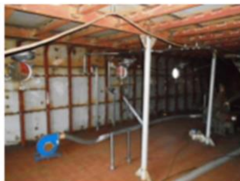
Foto nº 61 – Instalação das vigias
