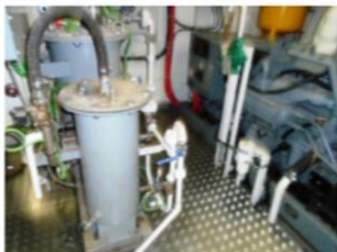
Foto nº 19 – Estrados da Praça de maquinas
