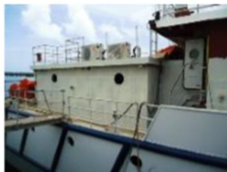
Foto nº 5 – Pintura da casaria
