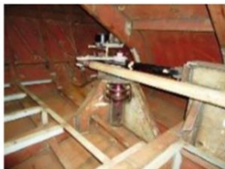
Foto nº 29 – Máquina do leme de boreste
