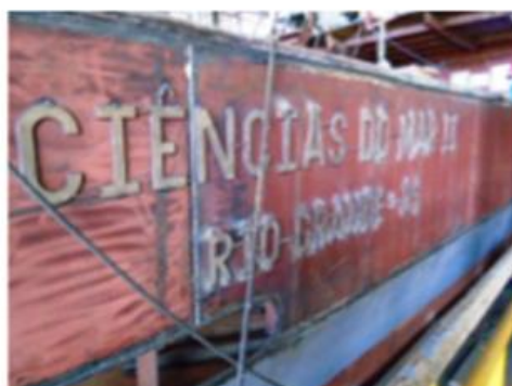
Foto nº 23 – Soldagem do nome
