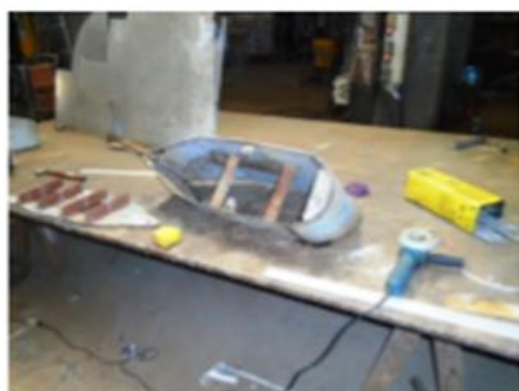
Foto nº 14 – Fabricação de domo
