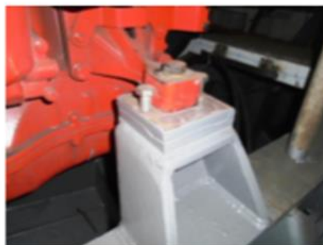
Foto nº 41 – Calço do MCP com resina
