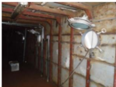
Foto nº 60 – Instalação das vigias
