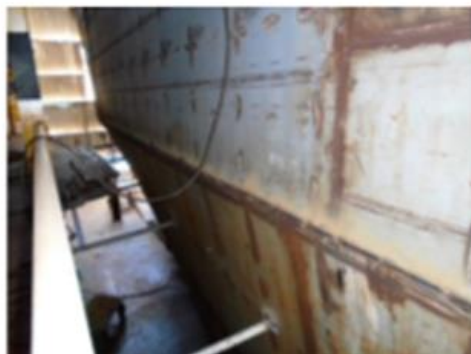
Foto nº 43 – Conclusão da soldagem do castelo
