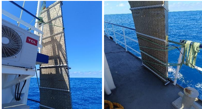
Figura 46. Serviço de fabricação de rampa de acesso.
