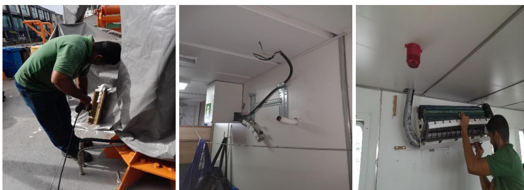
Figura 15. Serviço de manutenção dos aparelhos de ar-condicionado e instalações elétricas.
