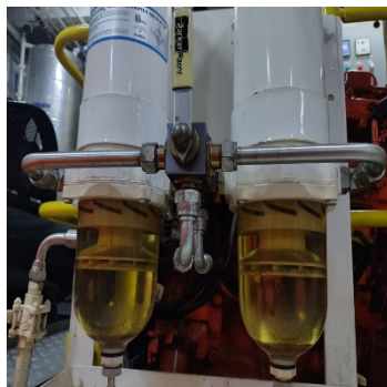
Figura 20. Instalação de cubas do filtro do MCP.
