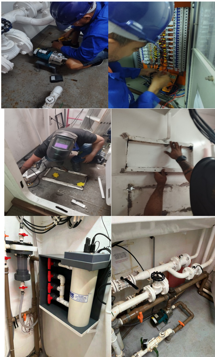
Figura 33. Serviços de serralharia e elétrica para instalação do termosal e o equipamento termosal instalado.
