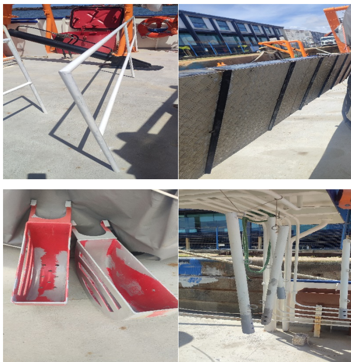
Figura 17. Tratamento e pintura dos itens de segurança.
