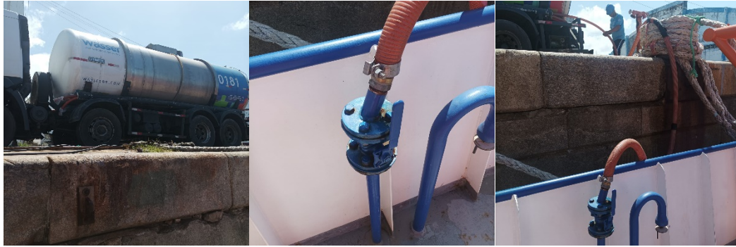
Figura 46. Conexão e recebimento de água potável.
