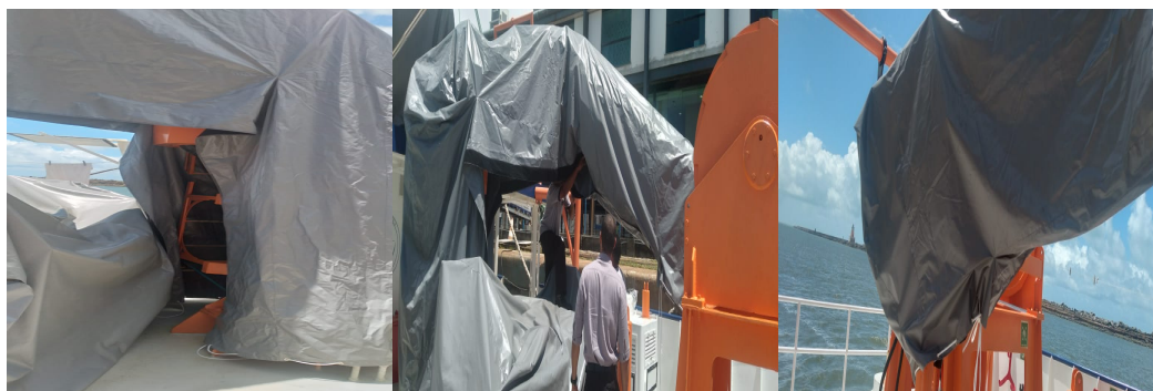
Figura 64. Cobertura para o guindaste.
