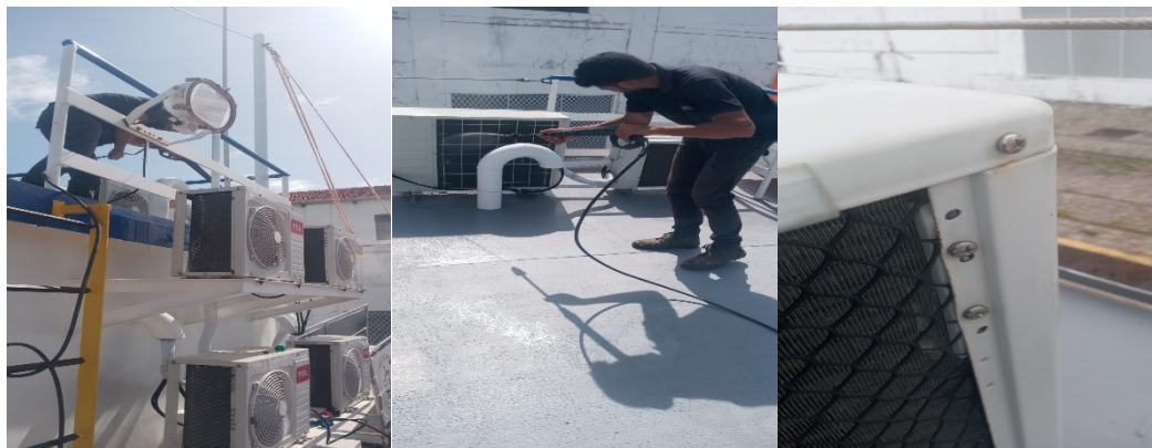
Figura 13. Serviço de manutenção dos aparelhos de ar-condicionado.
