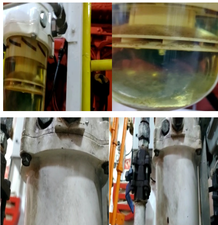
Figura 21. Instalação de copos nos filtros Raccor dos MCA's.
