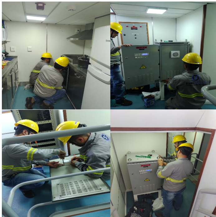
Figura 28. Serviços elétricos realizados pela Engeficaz.
