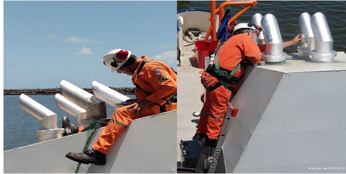
Figura 18. Pintura na chaminé.
