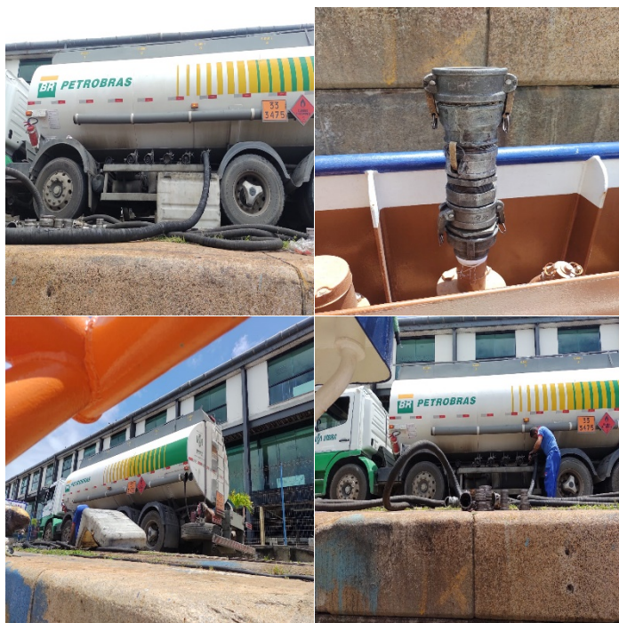
Figura 40. Recebimento de óleo combustível para os motores.
