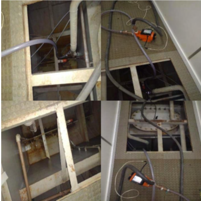
Figura 26. Imagens do procedimento de limpeza nas dalas.
