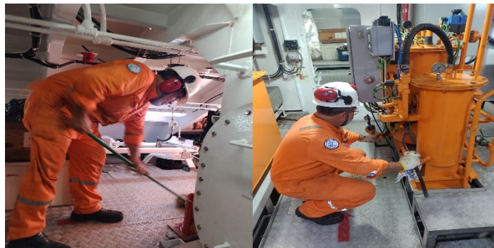
Figura 5. Serviços de limpeza na praça de máquinas.
