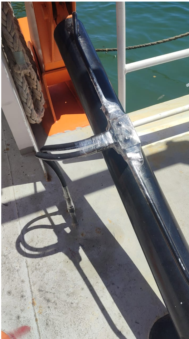
Figura 22. Manutenção do sistema hidráulica da embarcação.
