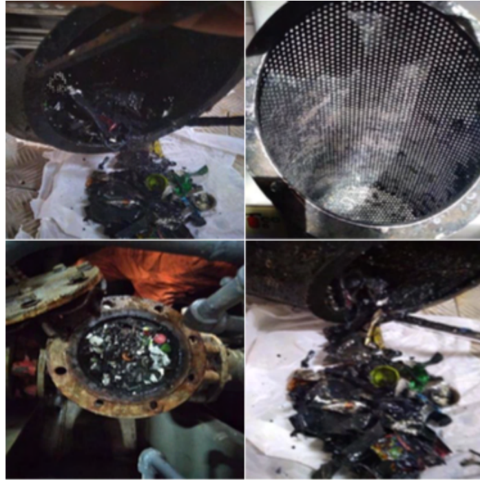
Figura 3. Imagem da caixa de máquina e retirada das impurezas.
