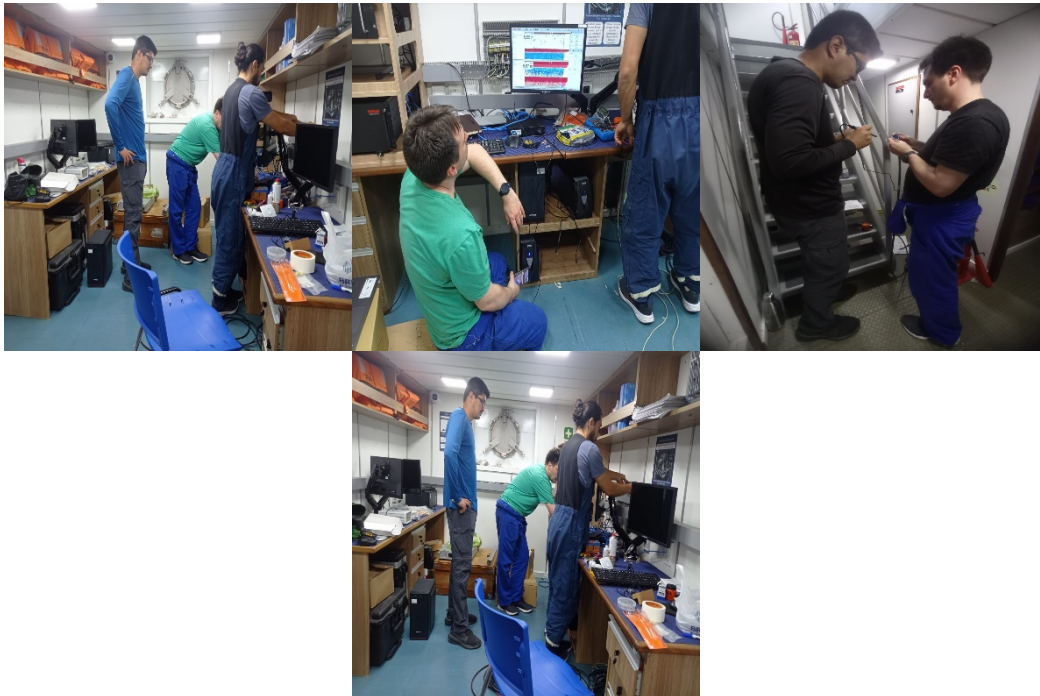
Figura 68. Técnicos na instalação dos equipamentos científicos.
