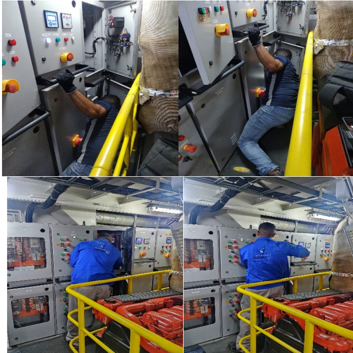
Figura 32. Substituição do disjuntor no quadro elétrico.
