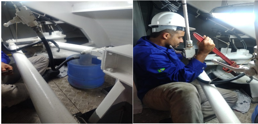
Figura 37. Reparo da máquina do leme.
