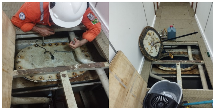
Figura 30. Vedação do tanque séptico.
