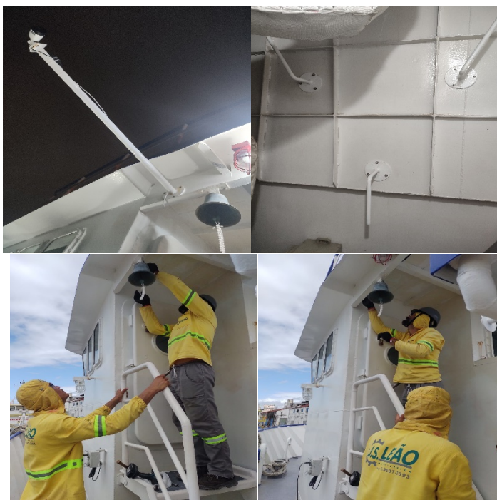
Figura 48. Instalação dos suportes para câmeras e cabos elétricos.
