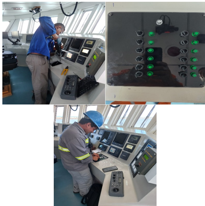
Figura 38. Instalação do quadro de luzes de navegação.
