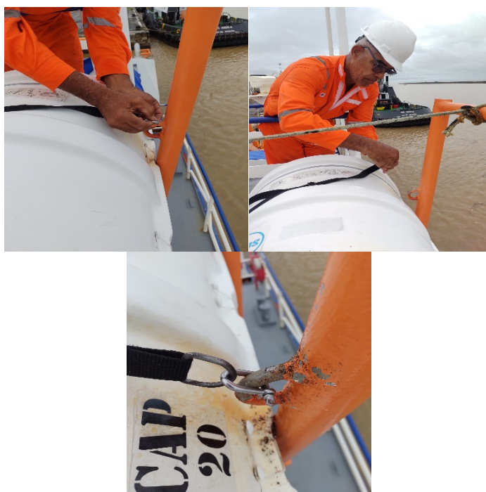
Figura 9. Manutenção dos berços das balsas salva-vidas.
