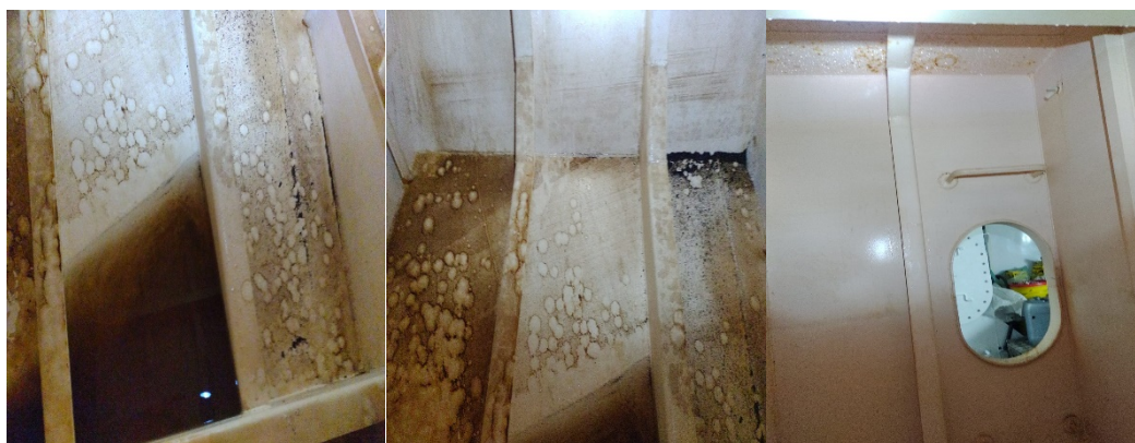
Figura 12. Limpeza dos tanques de água potável.
