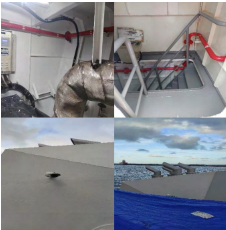
Figura 18 - Pintura da praça de máquinas e chaminé.
