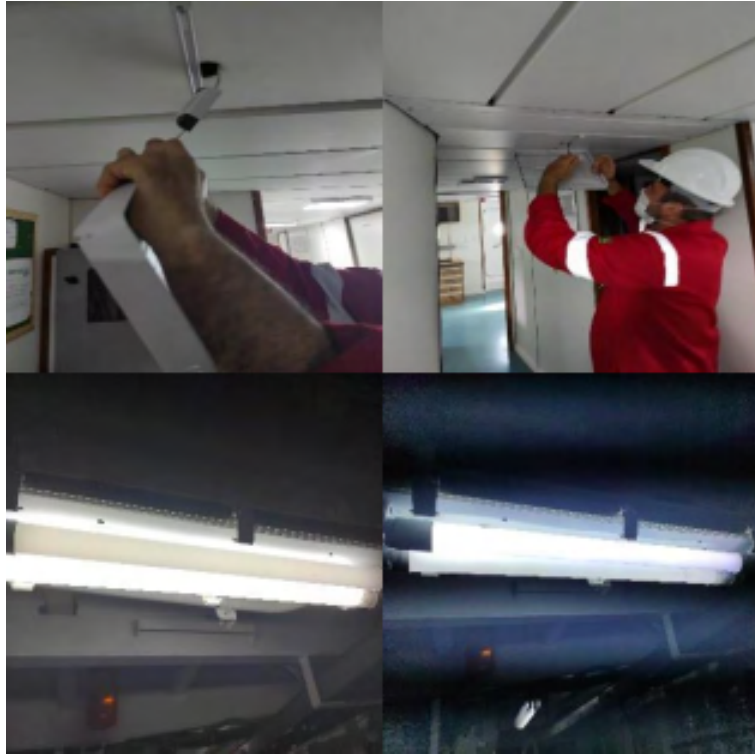
Figura 34 - Painel sobrepôr e lâmpada tubular substituídos.
