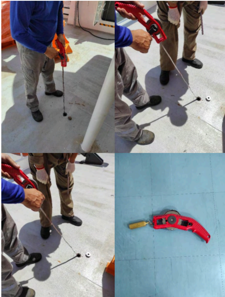
Figura 10 - Medição do existente óleo combustível.
