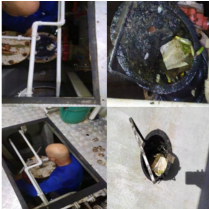
Figura 8 - Abertura e limpeza da caixa de mar.
