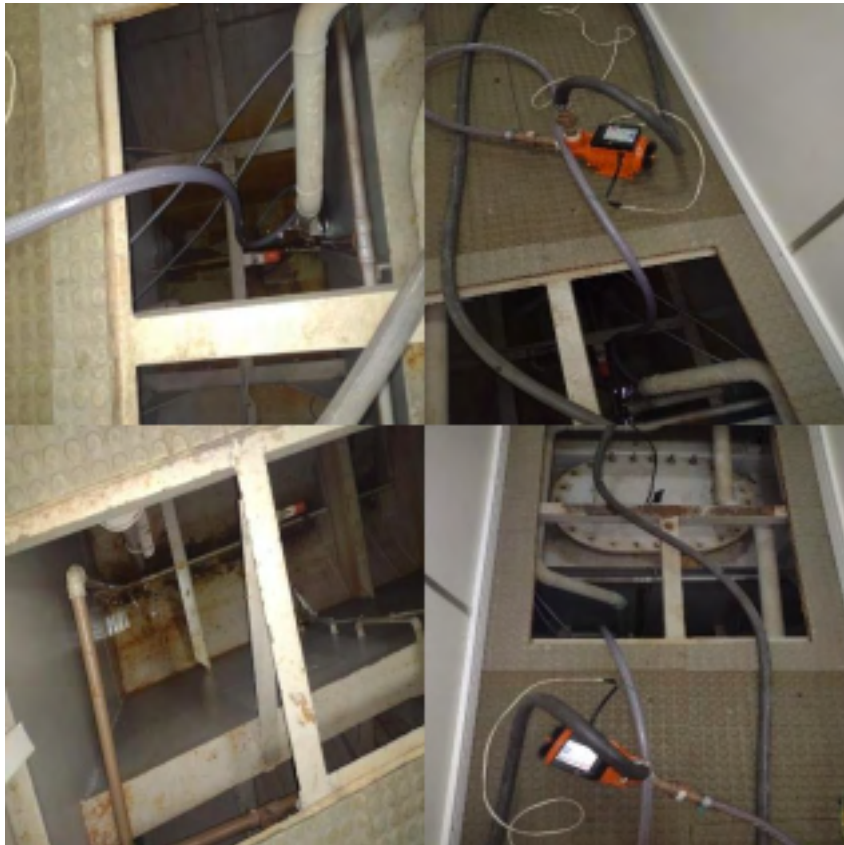
Figura 29 - Imagens do procedimento de limpeza nas dalas.
