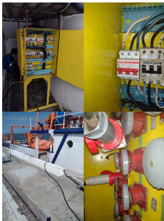
Figura 3 - Conexão do cabo elétrico, instalação do disjuntor e tomada.
