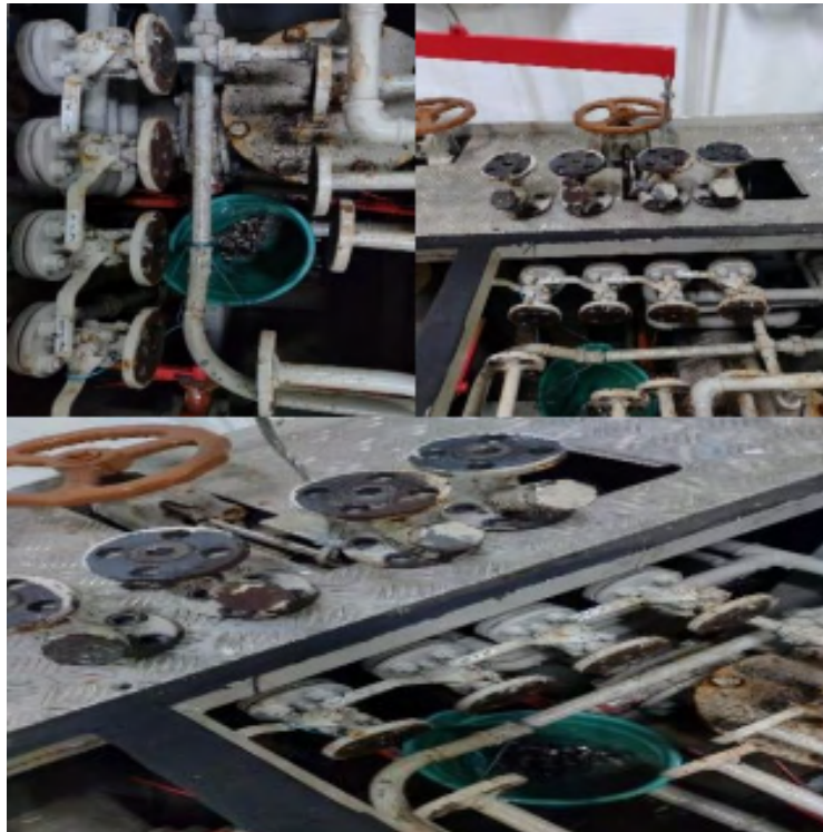
Figura 27 - Piano de válvulas desmontado para acesso aos filtros.
