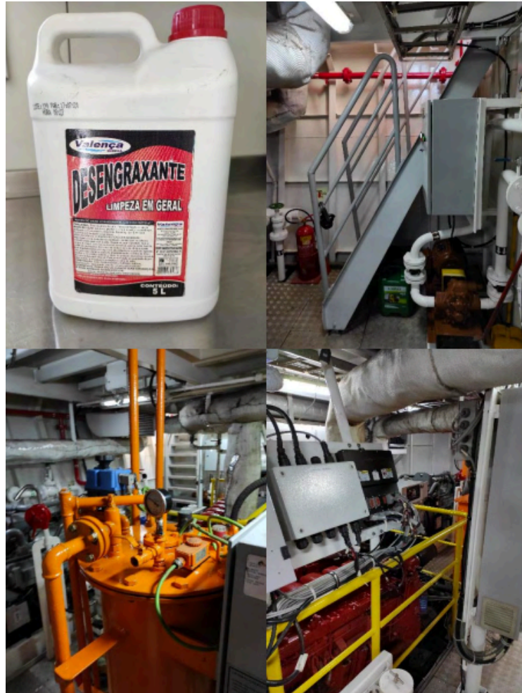
Figura 6 - Serviços de limpeza , na praça de máquinas.
