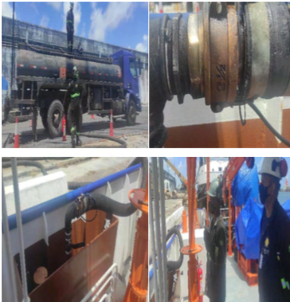
Figura 35 - Procedimento para retirada do óleo diesel para efetuar limpeza nos tanques.
