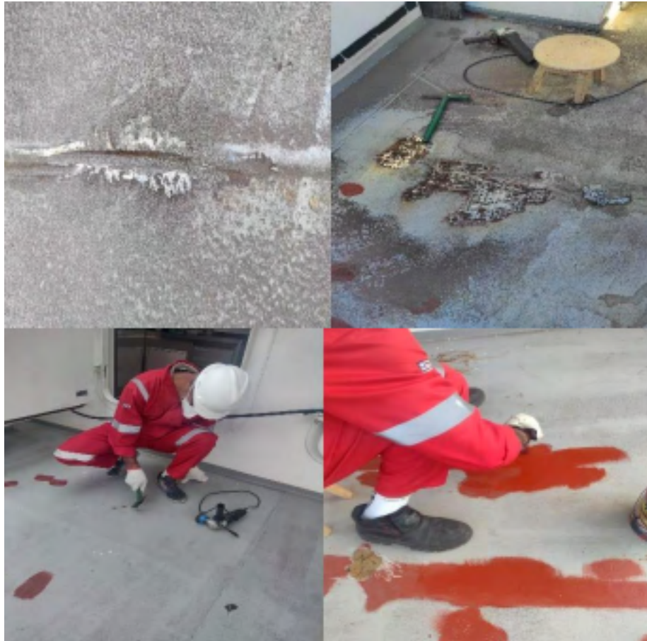
Figura 16 - Tratamento de pintura realizado no convés principal.
