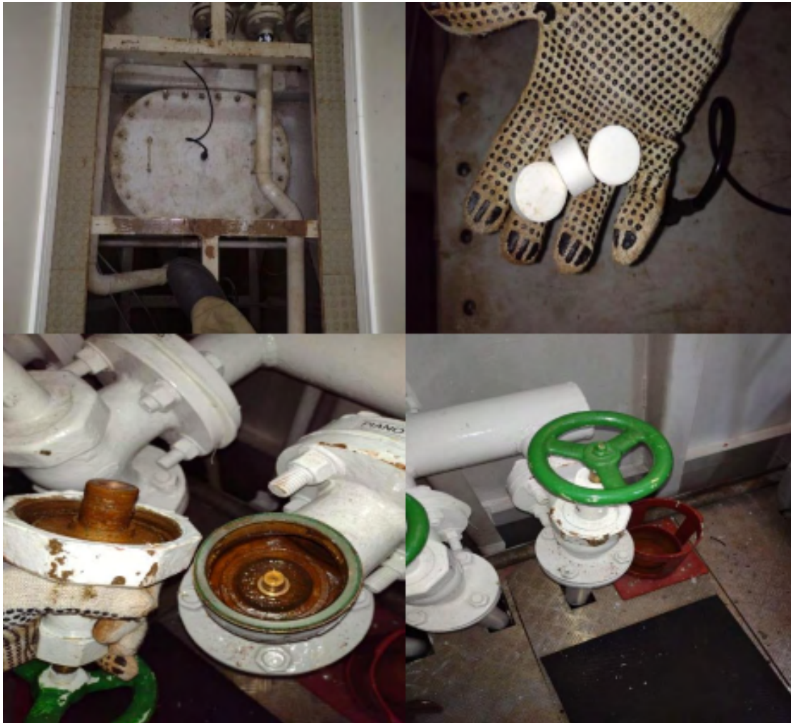
Figura 9 - Inspeção e manutenção das redes do navio.
