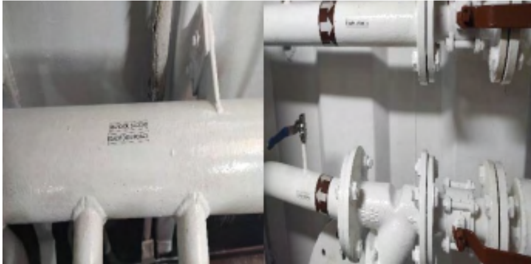
Figura 30 - Válvulas tratadas na praça de máquinas.
