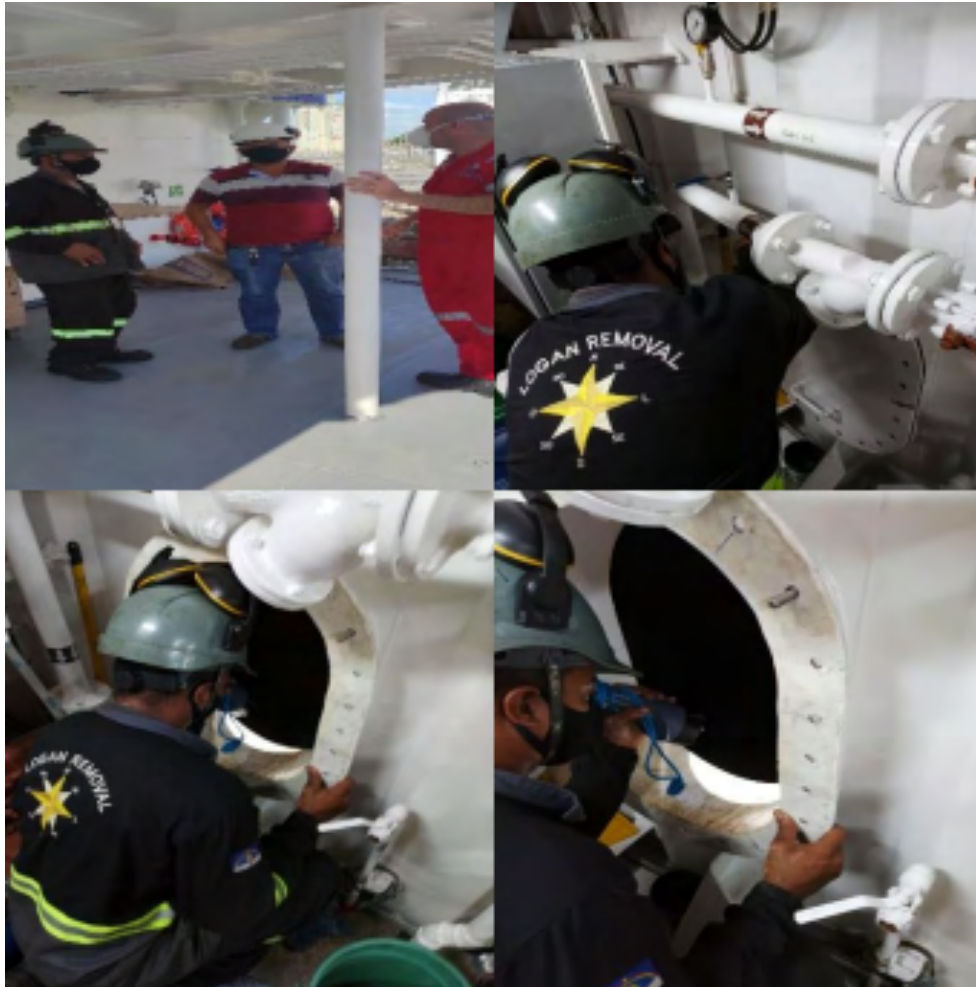
Figura 23 - Técnicos da empresa durante a inspeção dos tanques a bordo.
