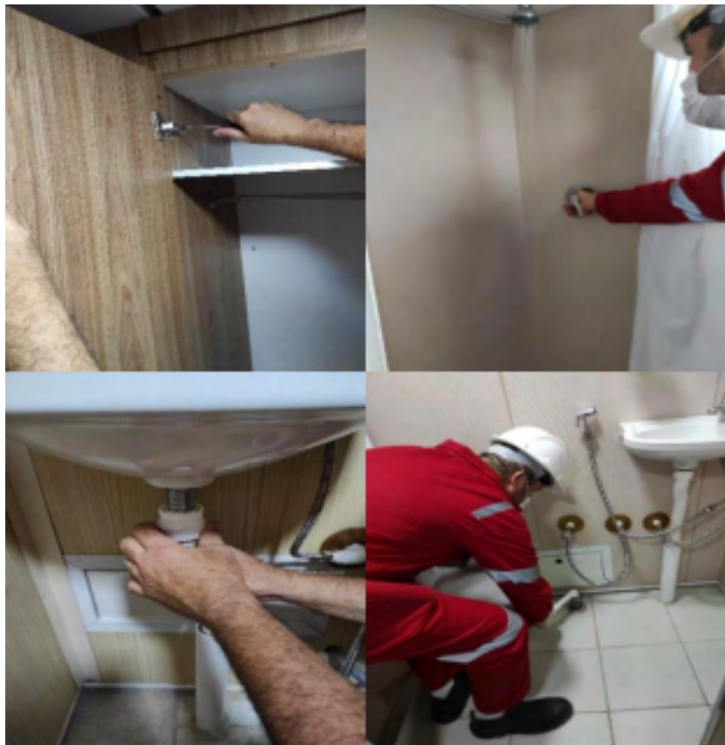
Figura 47 - Ajuste de parafusos com folgas e vedações nas conexões dos banheiros.
