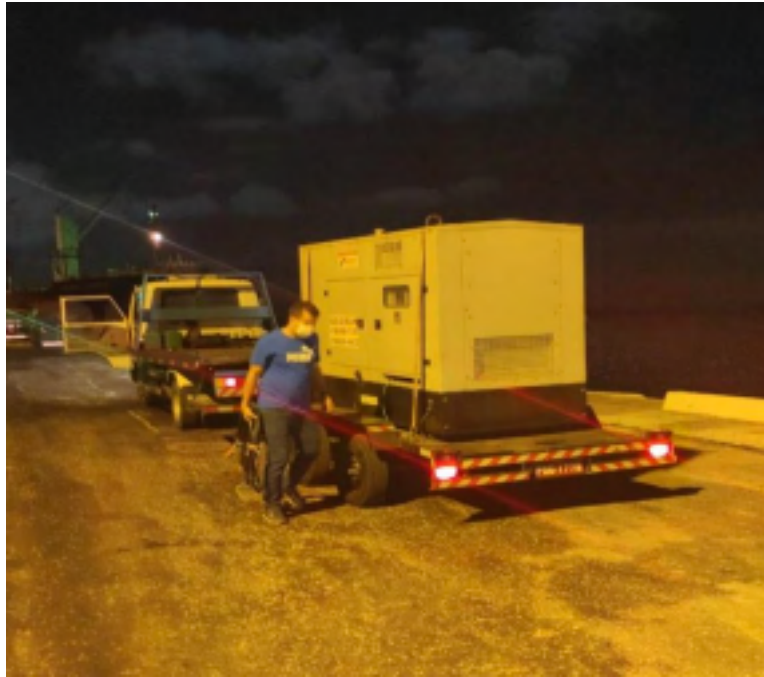
Figura 2 - Material para a Instalação do Diesel Gerador no cais do Porto de Recife - PE.
