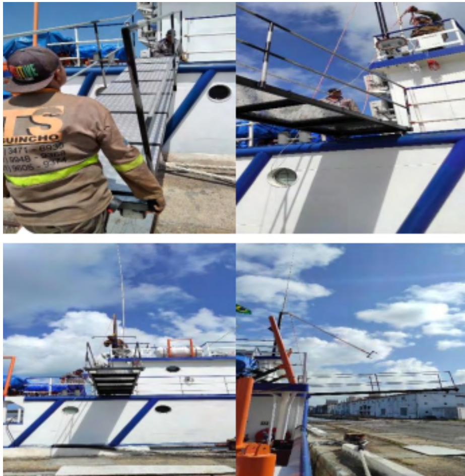
Figura 51 - Instalação da Rampa de acesso no CM IV.
