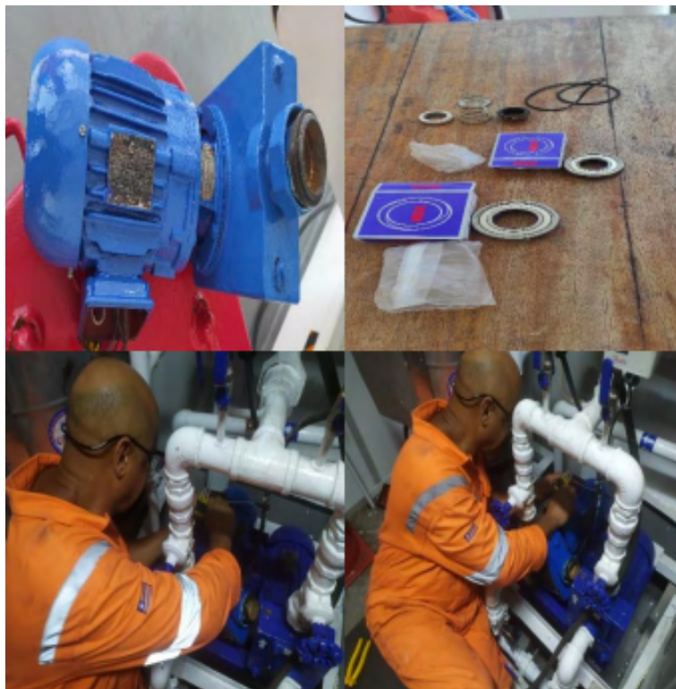
Figura 22 - Bomba de água potável instalada no berço e peças substituídas.
