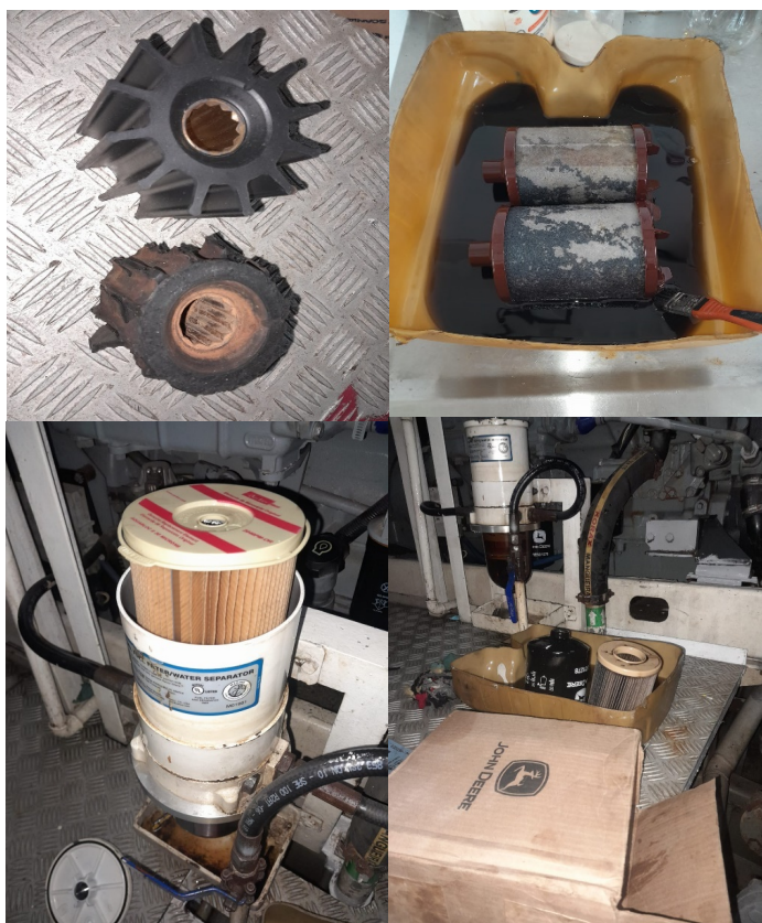
Figura 4. Substituição de rotores danificados e limpeza/substituição dos filtros dos motores.
