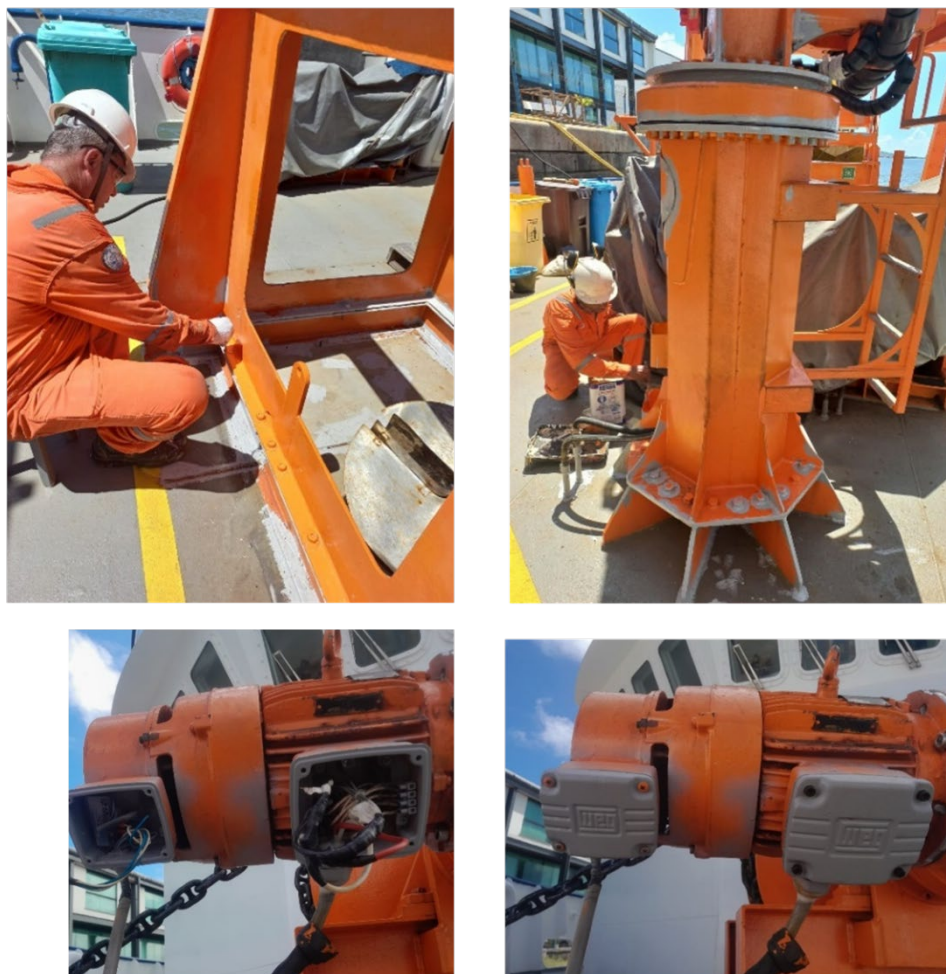
Figura 5. Manutenção nas estruturas do guinchos e molinetes.
