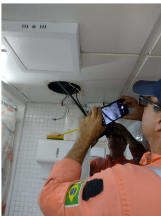
Figura 7. Serviço de reparo nas mangueiras, bombas de descargas e exaustores nos banheiros.
