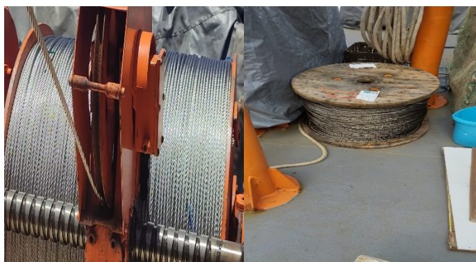
Figura 11. Troca dos cabos de aço (foto do novo e o usado).
