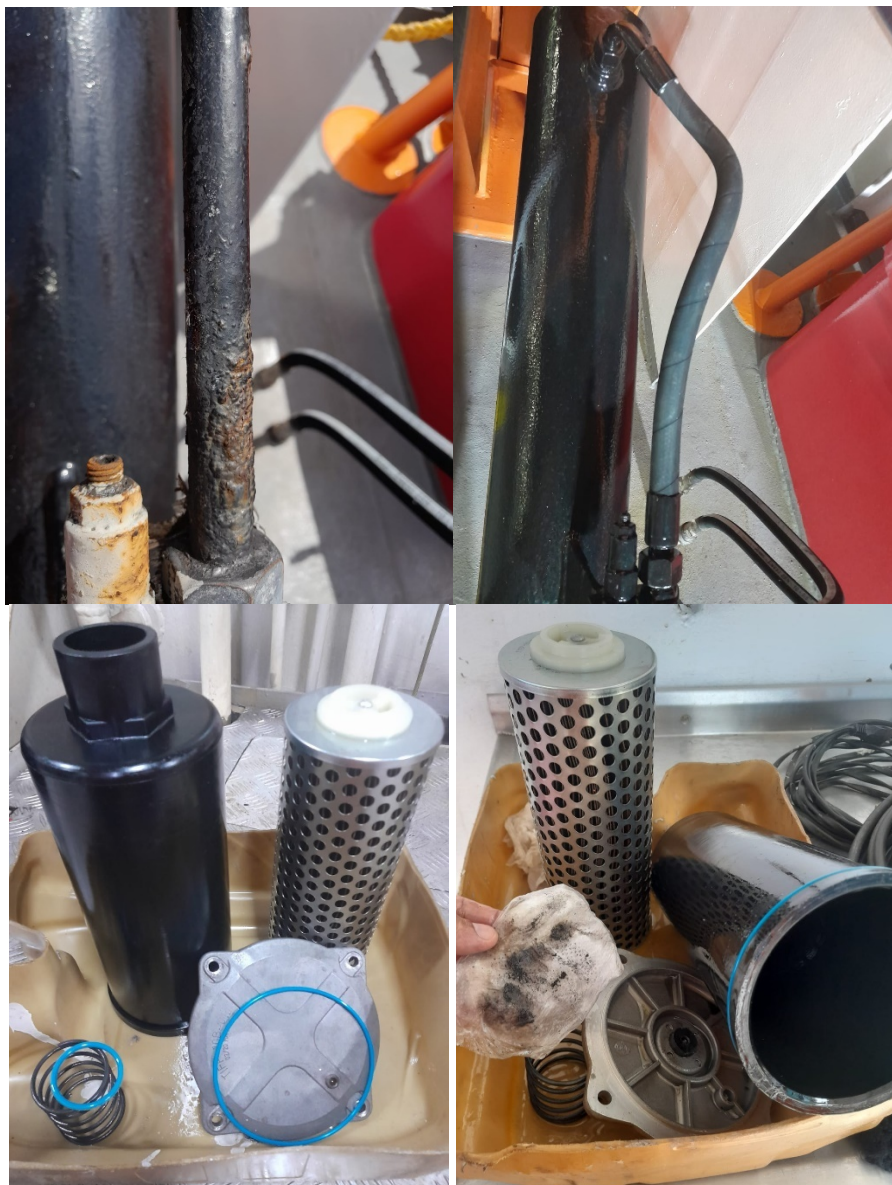
Figura 3. Serviço de substituição de mangueiras do equipamento hidráulico de convés (antes e depois) e serviço de limpeza do conjunto de filtragem do óleo da unidade hidráulica.
