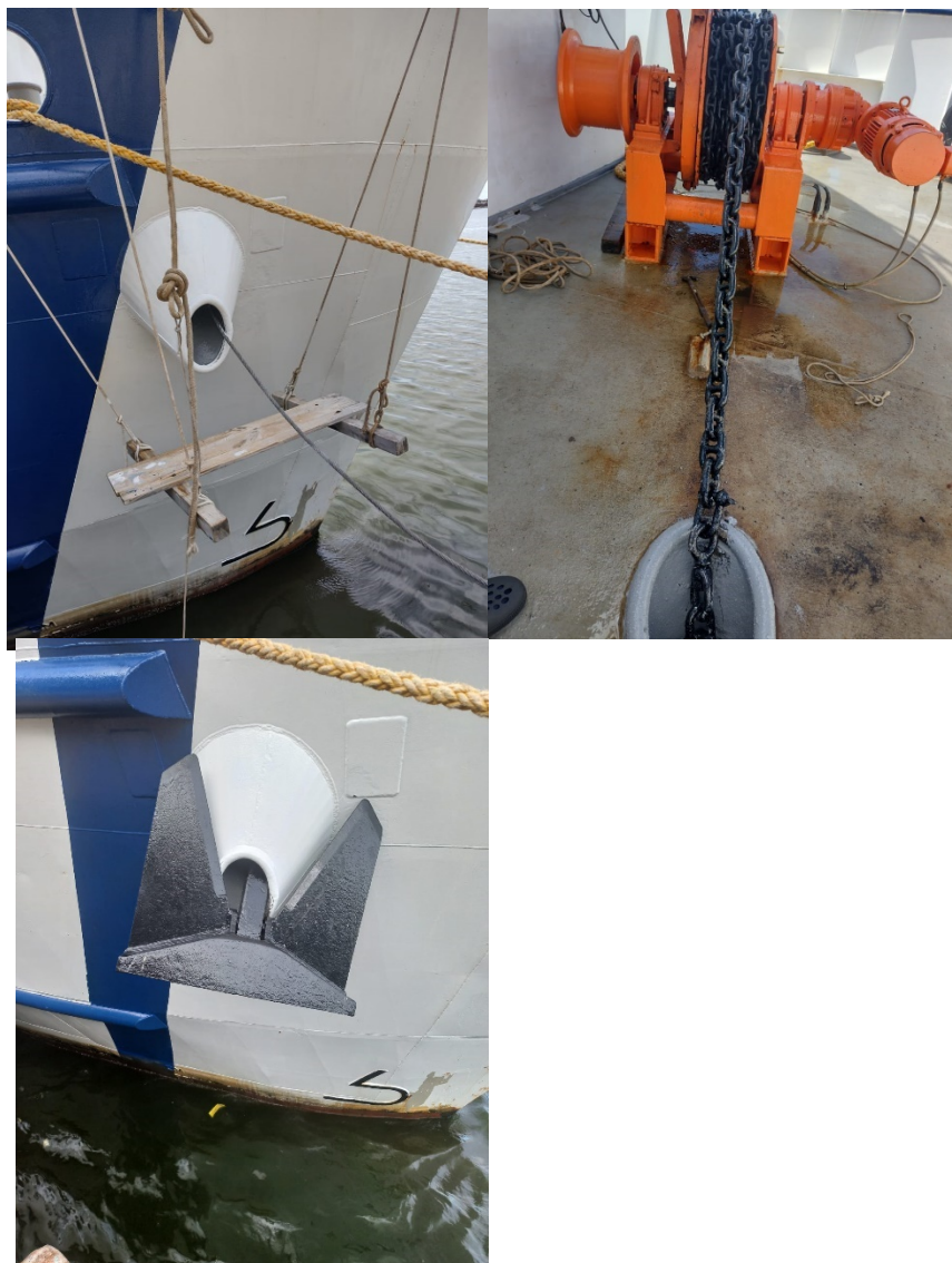
Figura 16. Exemplo de Manutenção e tratamento das correntes dispositivo de fundeio.
