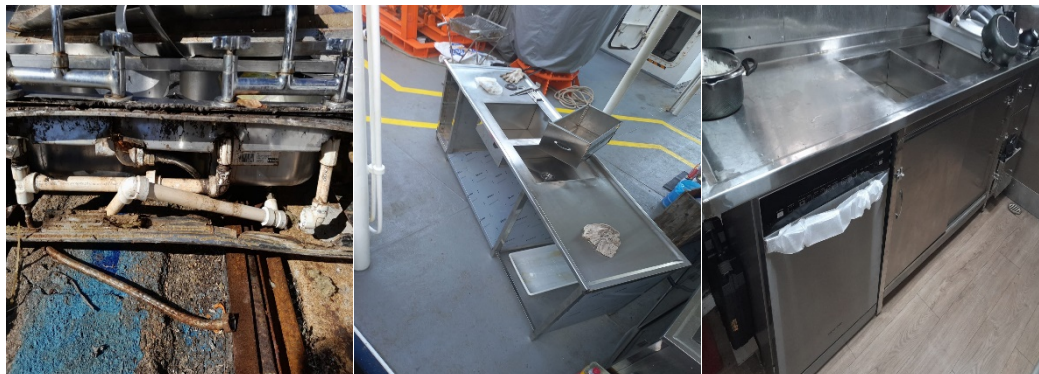
Figura 9. Serviço de substituição e instalação do balcão da cozinha da embarcação.
