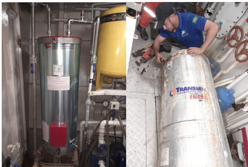
Figura 33. Serviço de instalação do aquecedor de água (Foto do novo instalado e o antigo retirado).
