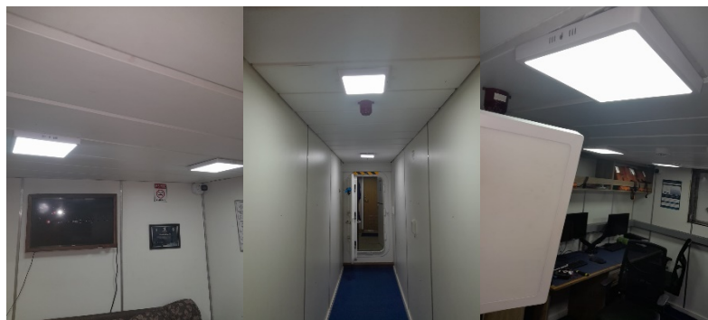
Figura 30. Exemplo de serviço de troca de luminárias.
