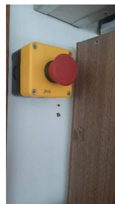
Instalação de botão de corte de energia
