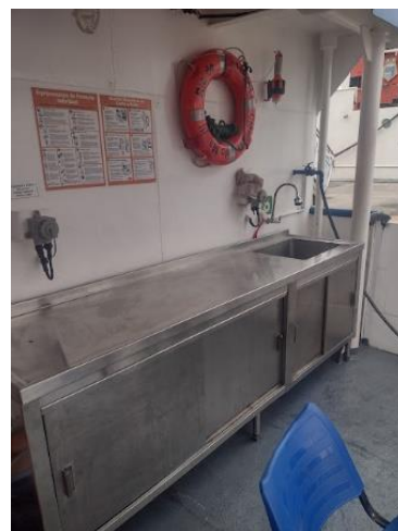
Instalação de armário bancada com tanque de água
