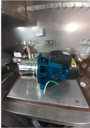
Instalação de bomba para água salgada
