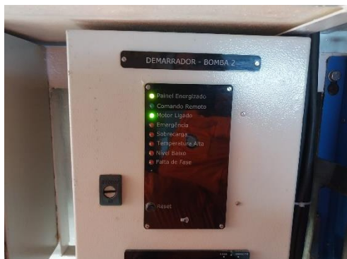
Conserto de sistema de alarmes
