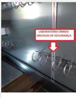
Instalação de argolas de amarração
