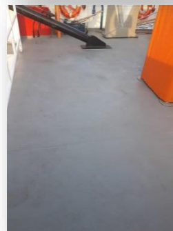
Pintura antiderrapante do piso
