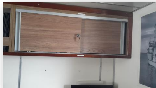
Instalação de tranças nos armários
