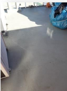
Pintura antiderrapante do piso
