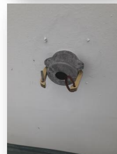
Abertura de tomada na parede externa do lab. Hidro.acústico
