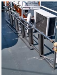
Confecção de escada de aço para o costado
