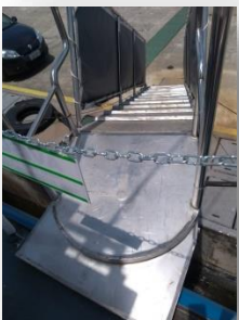
Manutenção e benfeitoria de Plataformas de acesso
