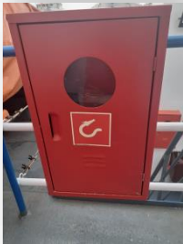
Instalação de caixa de incêndio
