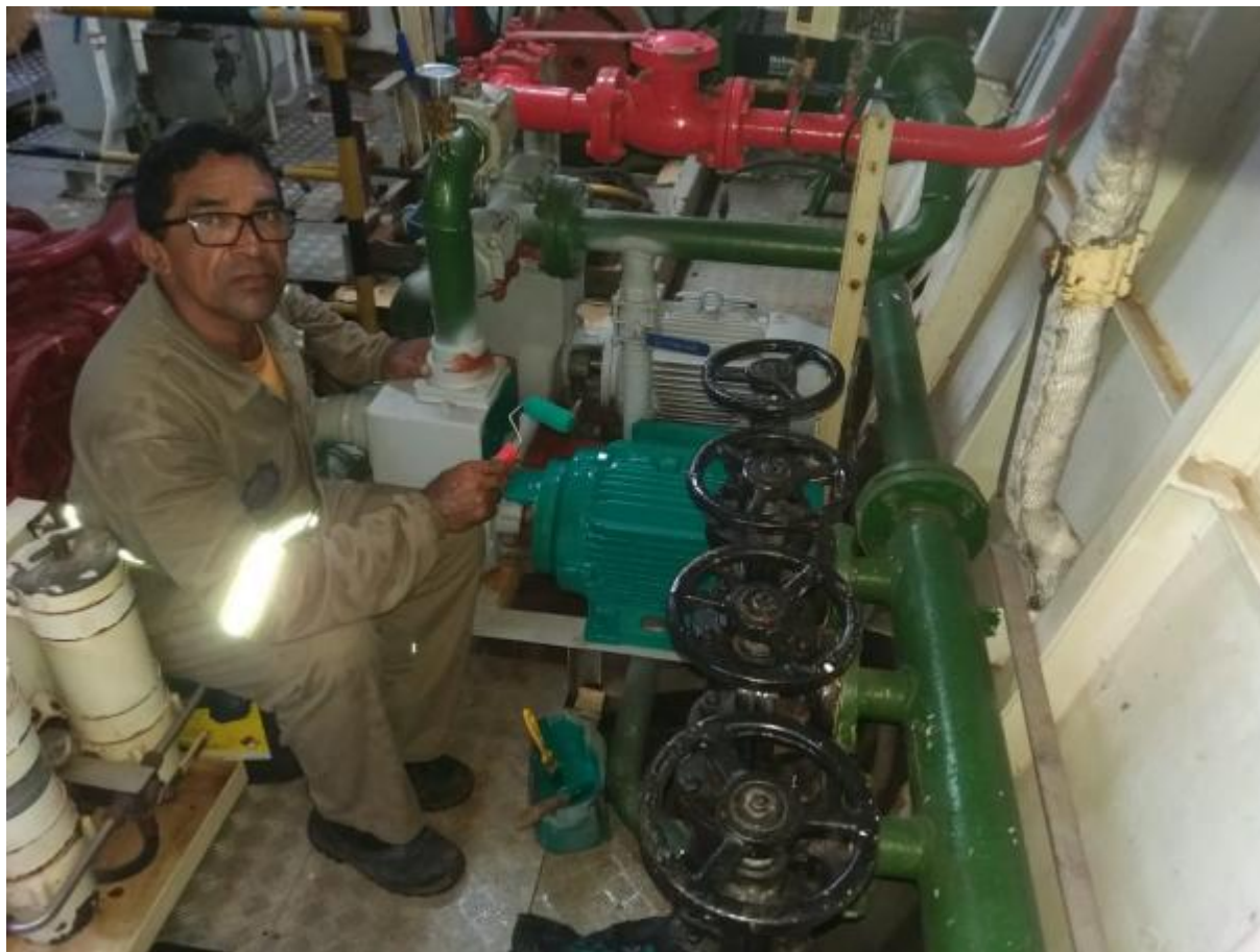
Figura 9 - Manutenção de motores na sala de máquinas. Maio/2022.
