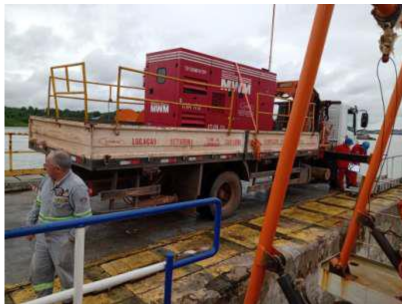
Figura 2 - Embarque do Gerador de 170KVA. Fevereiro de 2022.
