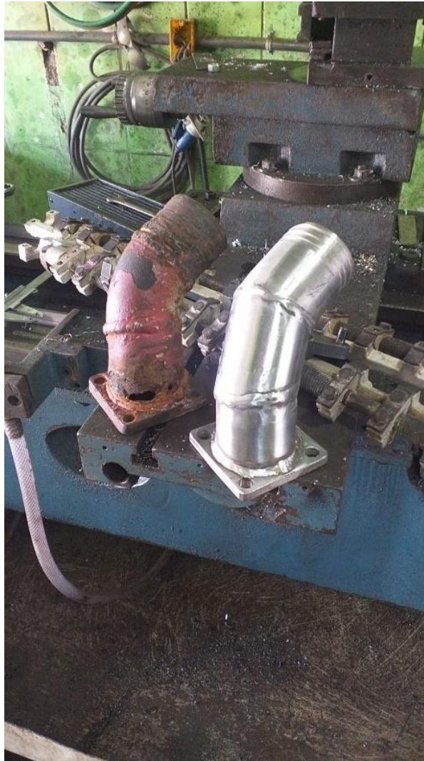
Figura 7 - Manutenção corretiva de conexão. Substituição por aço inox. Maio/2022.
