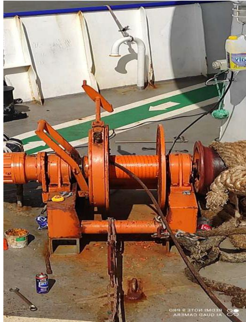
Figura 3 - Revisão do guincho da âncora e tratamento do cabo. Fevereiro de 2022.
