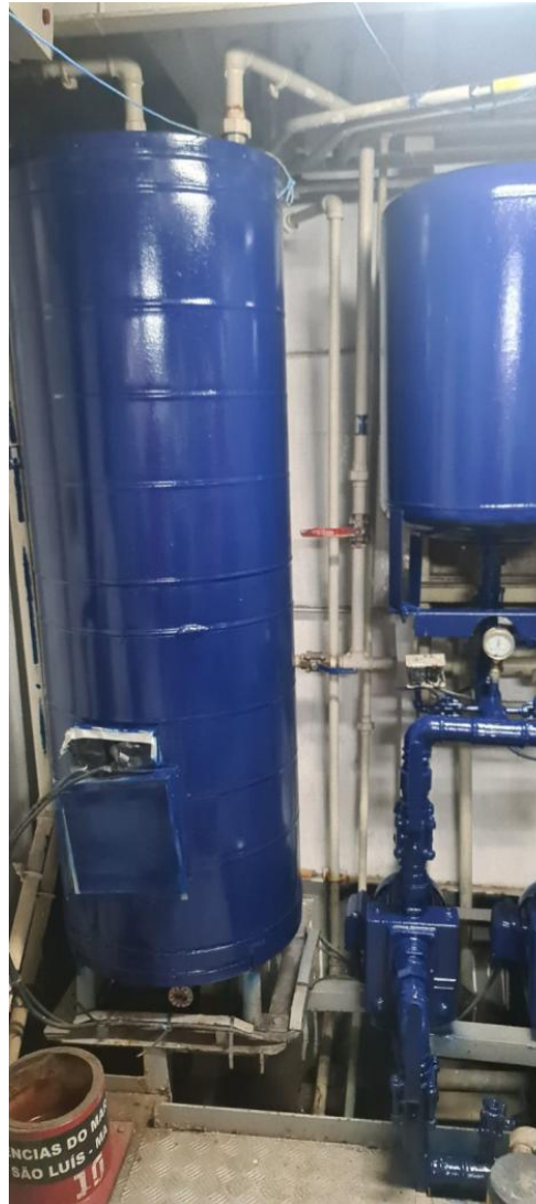
Figura 6 - Manutenção preventiva do vaso de pressão. Maio/2022.
