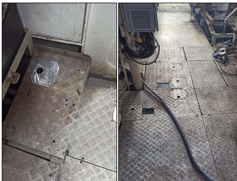
Item 15.19 - Fabricação e reforços das tampas de acesso as válvulas e desempenho dos estrados
