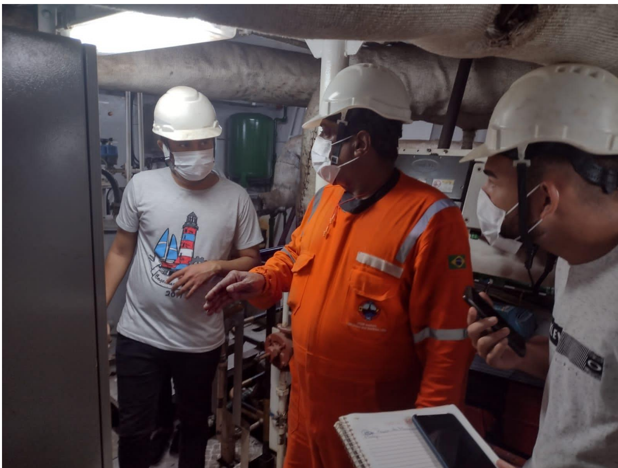
Figura 14- Aula na Praça de máquinas
