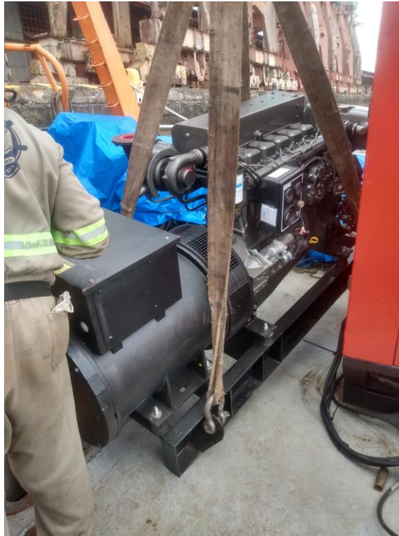
Figura 5b) Embarque dos dois geradores no NEP CM II.
