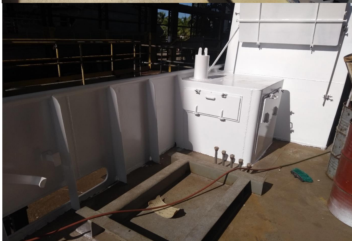
Descrição: Pintura da borda falsa do convés principal BB e BE. (80% concluído)
