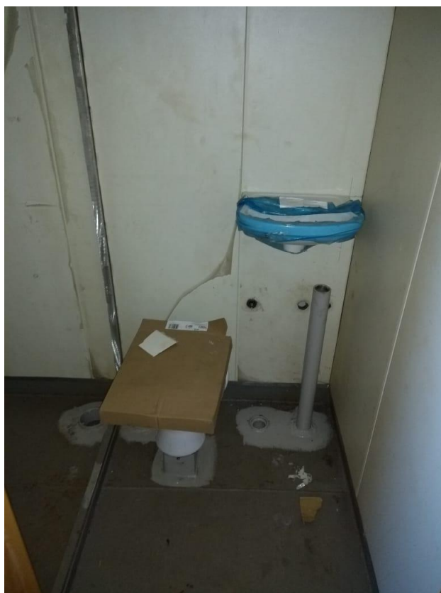
Foto 17: Unidade de banheiro.
