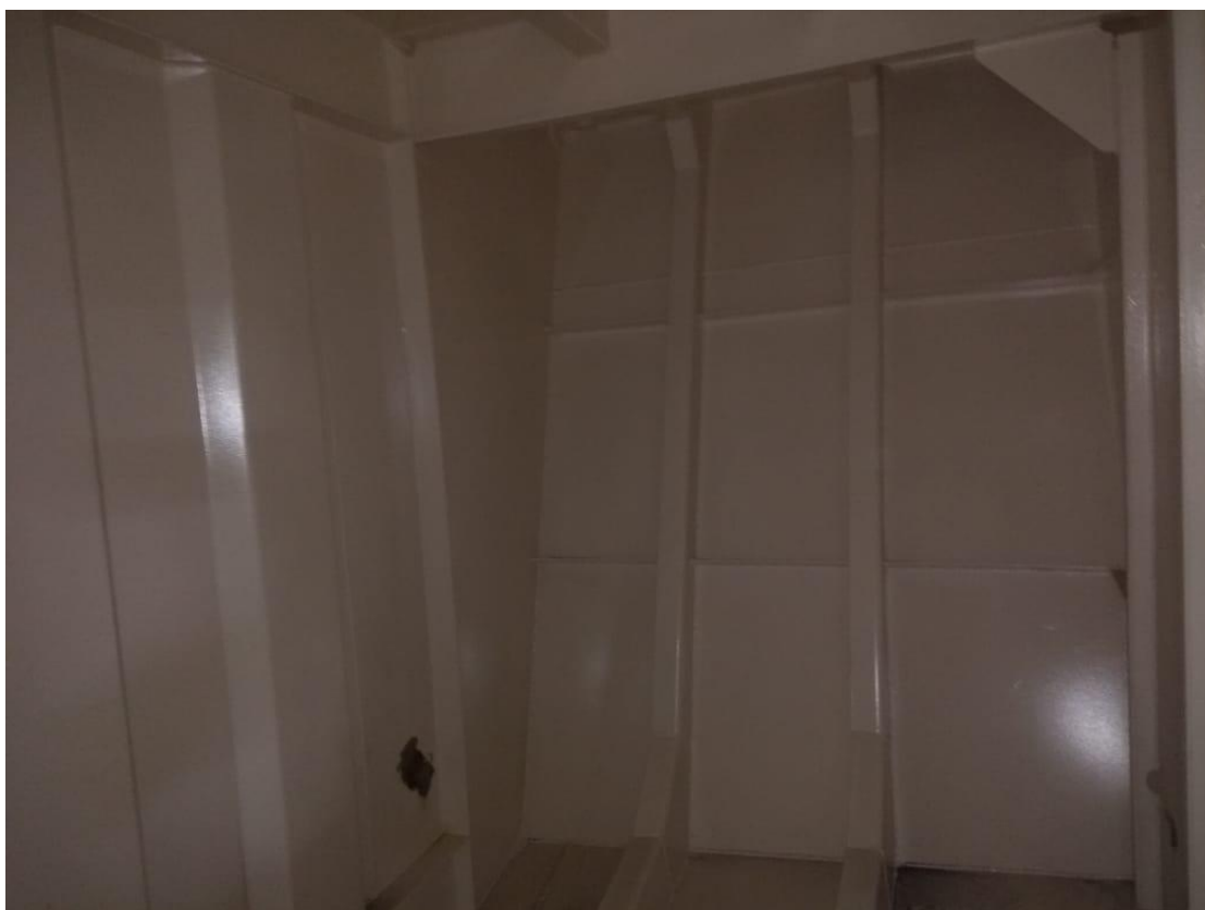
Foto 20: Parte interna do tanque de água doce.
