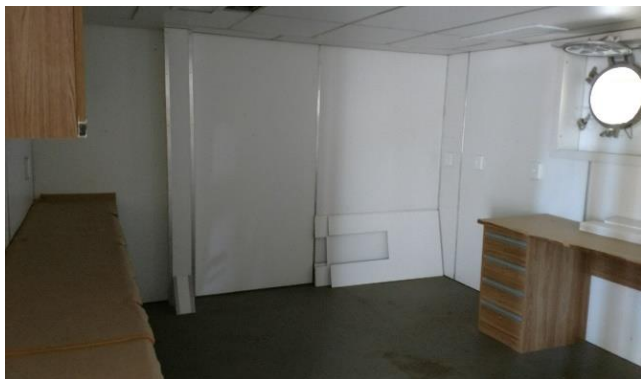
Foto 13 - laboratório seco no convés principal
