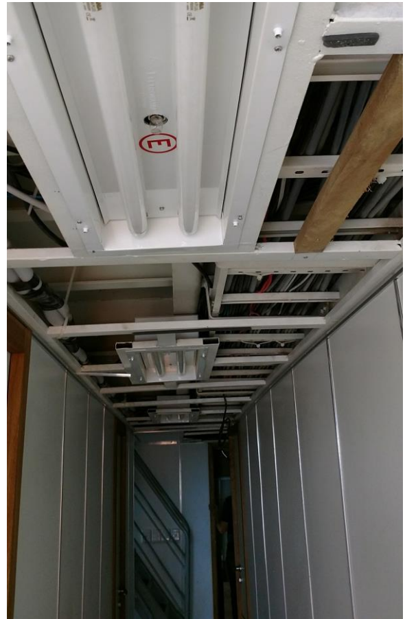
Foto 3 - Forro no convés principal aberto
