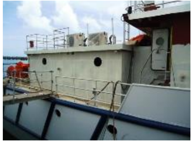
Foto nº 5 – Pintura da casaria
