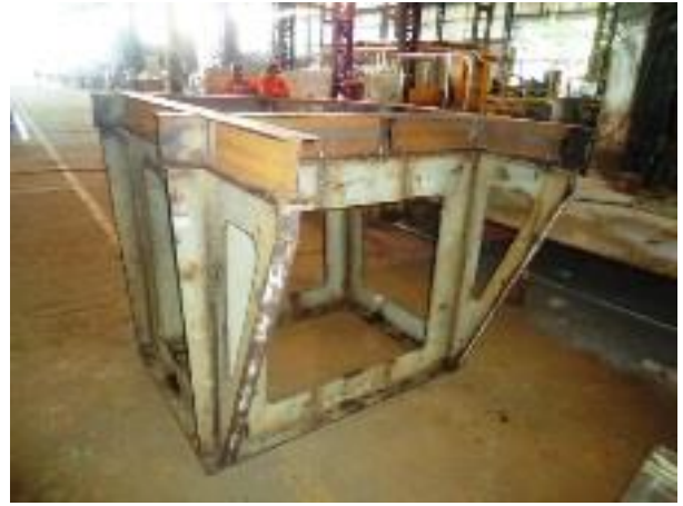
Foto nº 11 – Base do enrolador de rede
