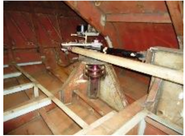
Foto nº 29 – Máquina do leme de boreste
