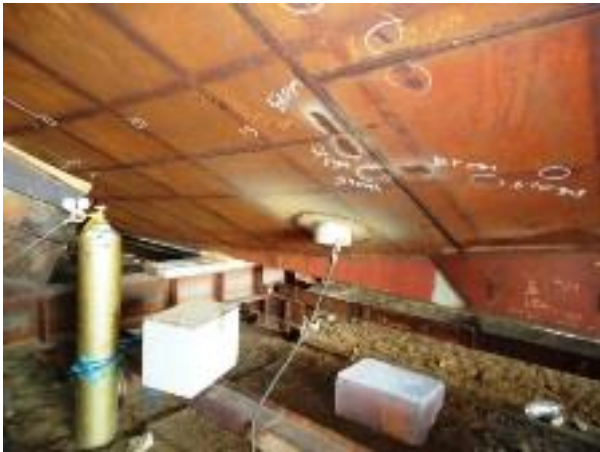
Foto nº 30 – Limpeza e reparos em soldas 654
