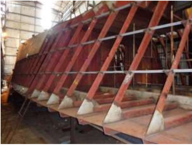
Foto nº 52 – Estrutura do casco 656
