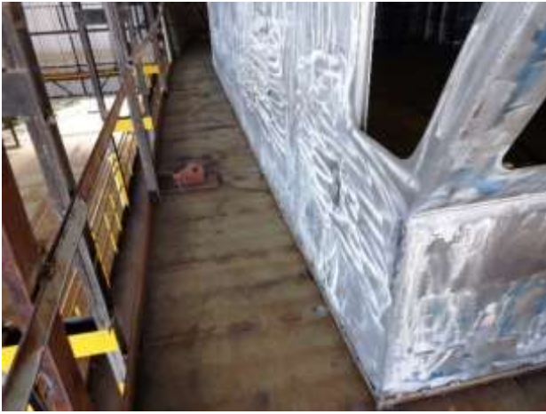
Foto nº 46 – Cabine alinhada e ponteada
