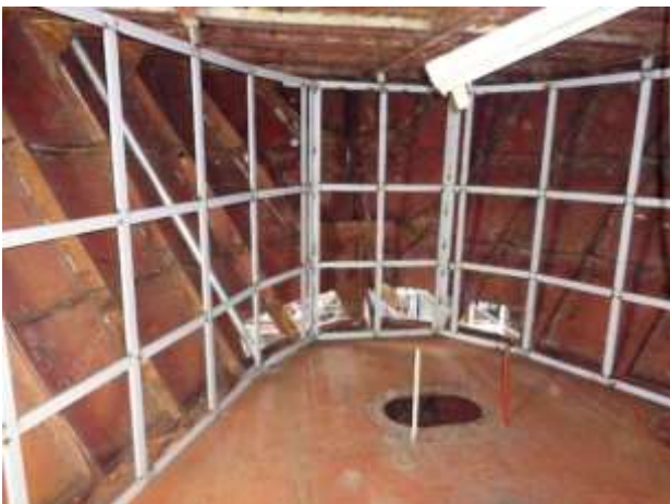
Foto nº 8 – Metalon na sala de estar
