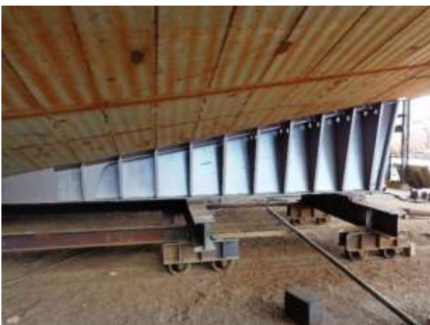
Foto nº 38 – Estrutura do skeg
