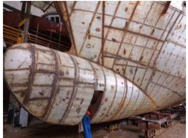
Foto nº 37 – Soldagem interna do bulbo
