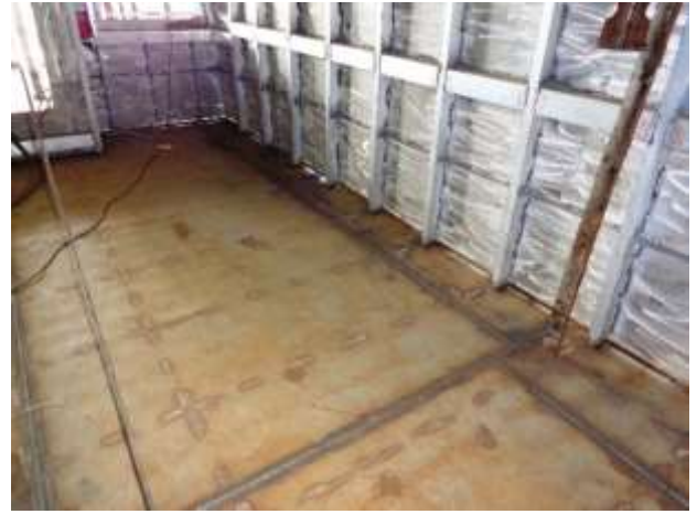
Foto nº 47 – Cabine alinhada e ponteada
