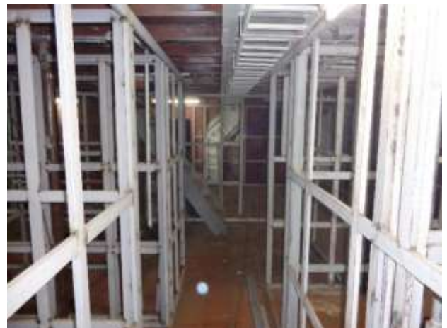
Foto nº 9 – Metalon e calhas no castelo
