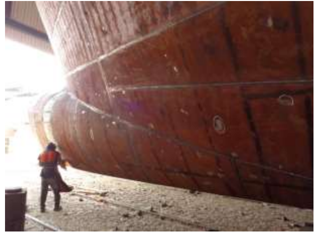
Foto nº 29 – Reparos em soldas no casco 654
