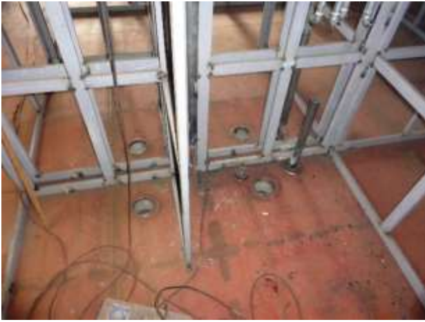
Foto nº 10 – Aberturas para hidráulica
