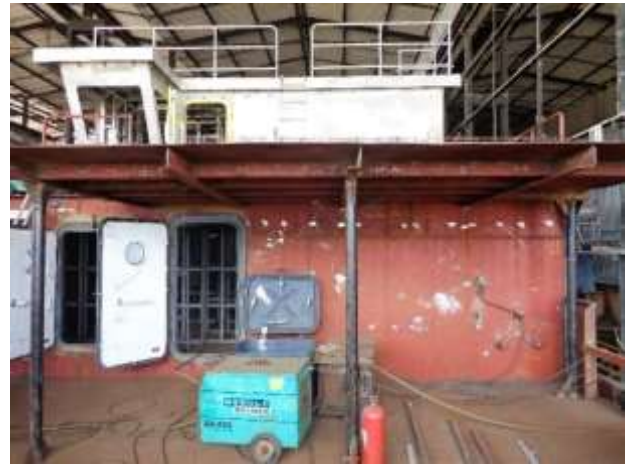
Foto nº 17 – Portas de acesso ao Castelo
