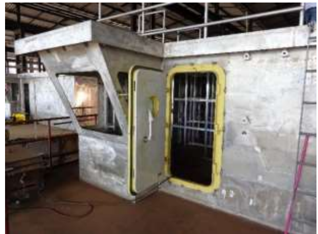
Foto nº 19 – Porta de acesso a cabine
