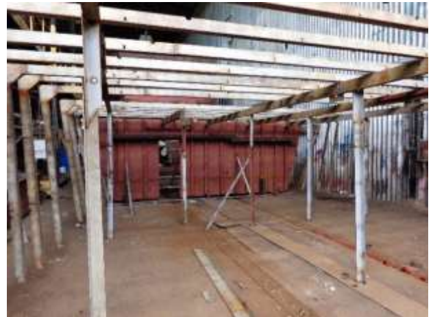
Foto nº 55 – Estrutural do castelo
