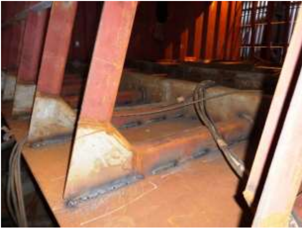
Foto nº 40 – Soldagem no casco 656
