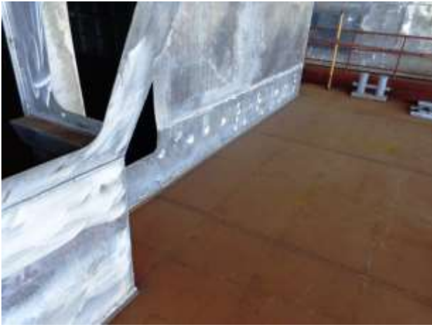
Foto nº 22 – Cabine soldada sobre castelo
