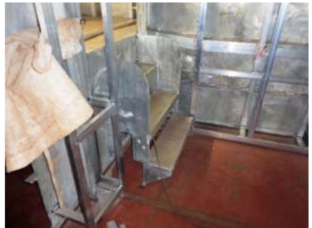
Foto nº 3 – Escada de acesso ao passadiço
