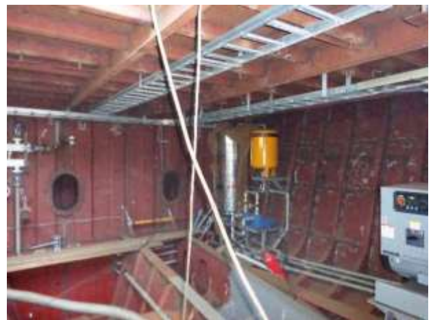
Foto nº 15 – Sistema hidroforo e calhas
