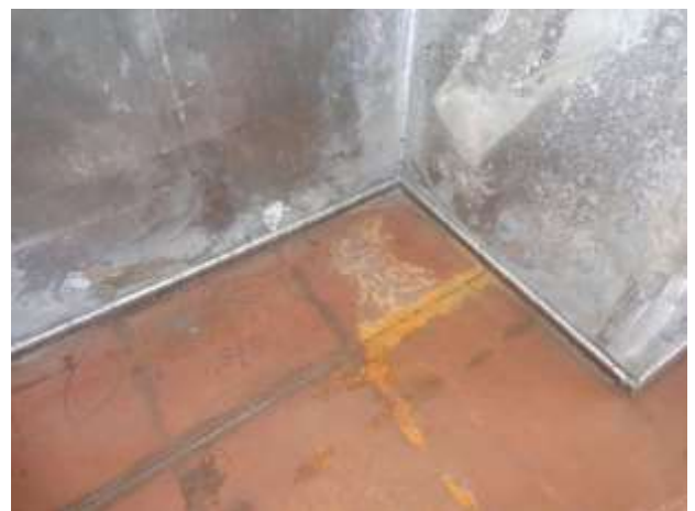
Foto nº 21 – Cabine soldada sobre castelo
