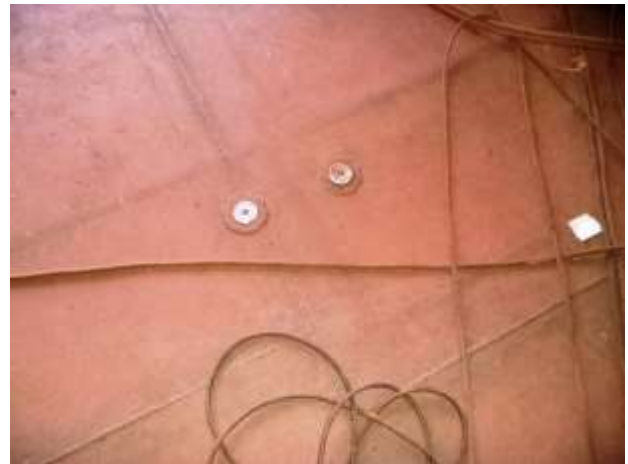
Foto nº 6 – Tubos de sondagem de tanques
