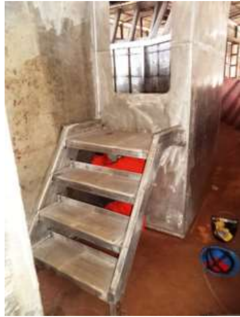
Foto nº 2 – Instalação de escadas externas
