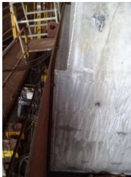
Foto nº 8 – Soldagem da chaminé na borda
