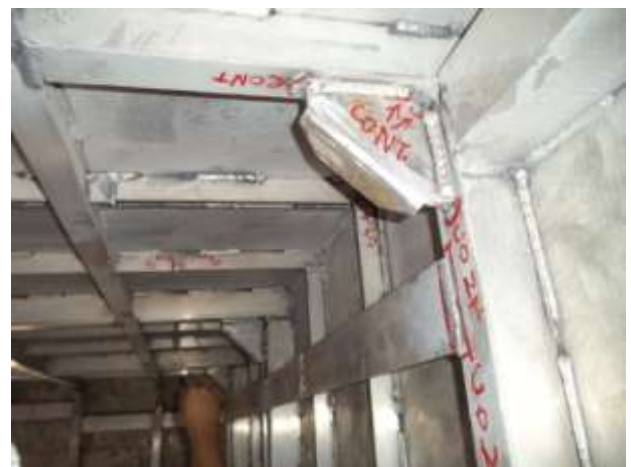
Foto nº 18 – Reparos nas soldas
