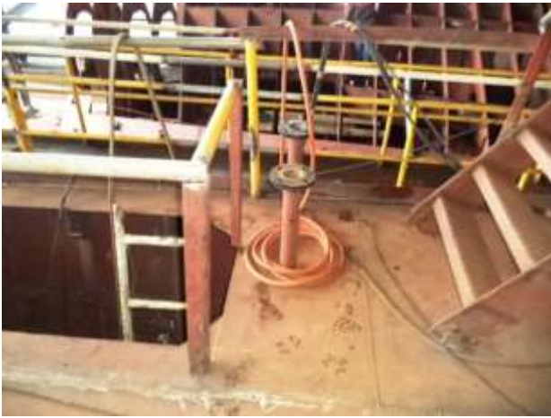
Foto nº 11 – Detalhes de penetrações no convés
