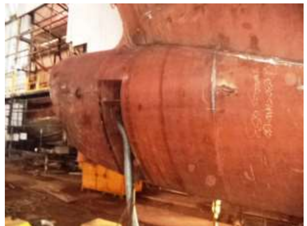
Foto nº 16 – Fechamento do bulbo
