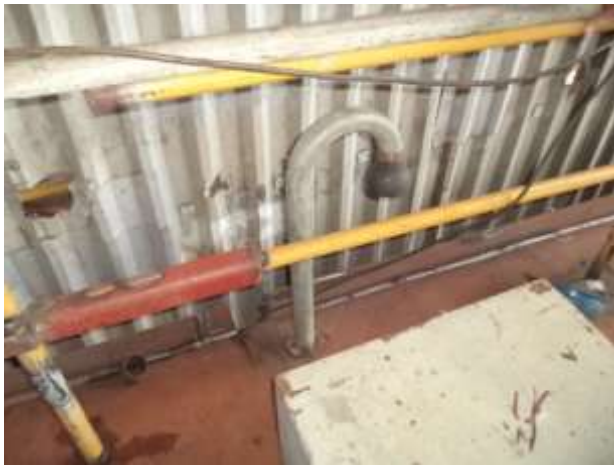
Foto nº 13 – Suspiro de tanque
