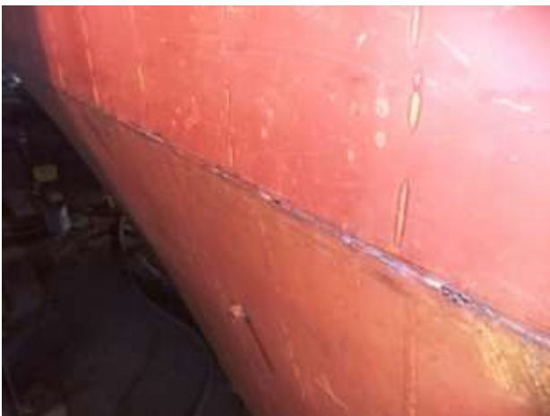
Foto nº 5 – Solda externa do castelo sobre o casco
