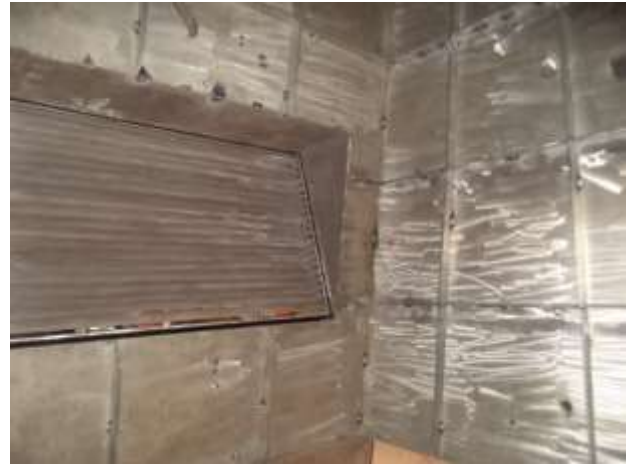
Foto nº 32 – Chaminé do casco 653
