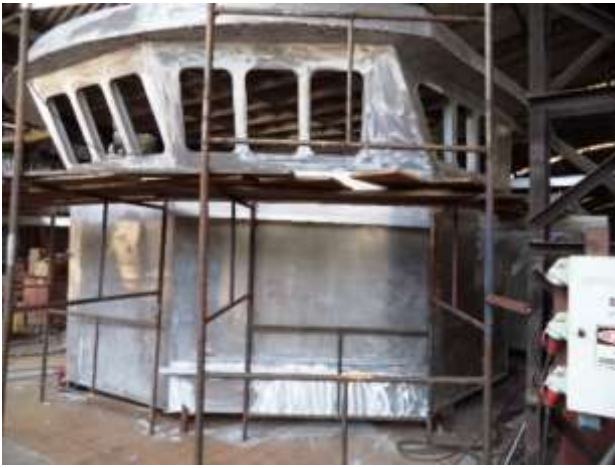
Foto nº 13 – Passadiço do casco 653
