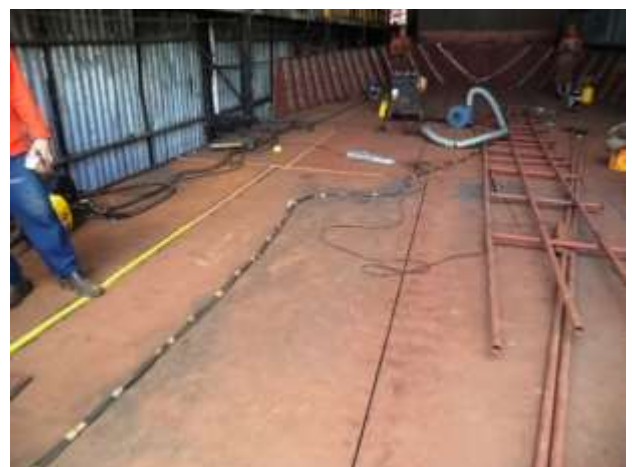
Foto nº 24 – Soldagem com back cerâmico
