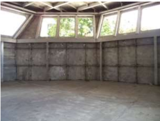
Foto nº 15 – Interior do passadiço do casco 653
