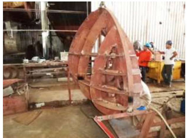
Foto nº 30 – Bulbo do casco 653
