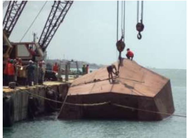
Foto nº 4 – Engate dos cabos dos guindastes
