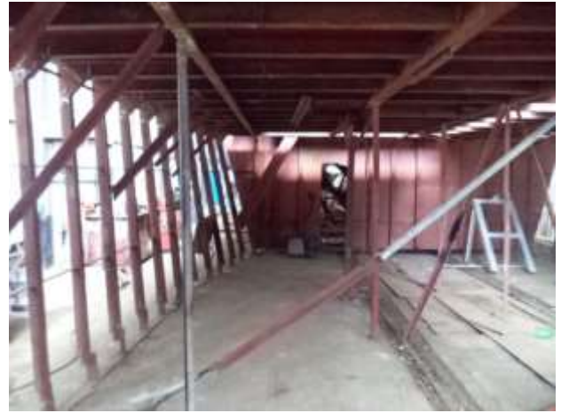
Foto nº 8 – Vista interna do bloco do castelo
