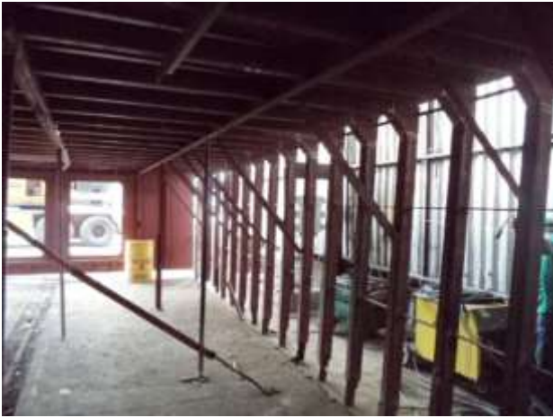
Foto nº 9 – Vista interna do bloco do castelo
