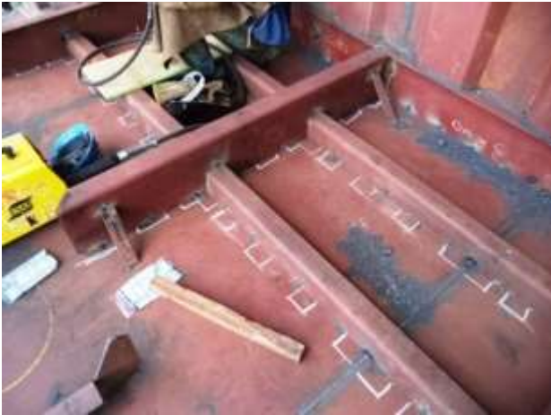
Foto nº 15 – Marcação para soldagem
