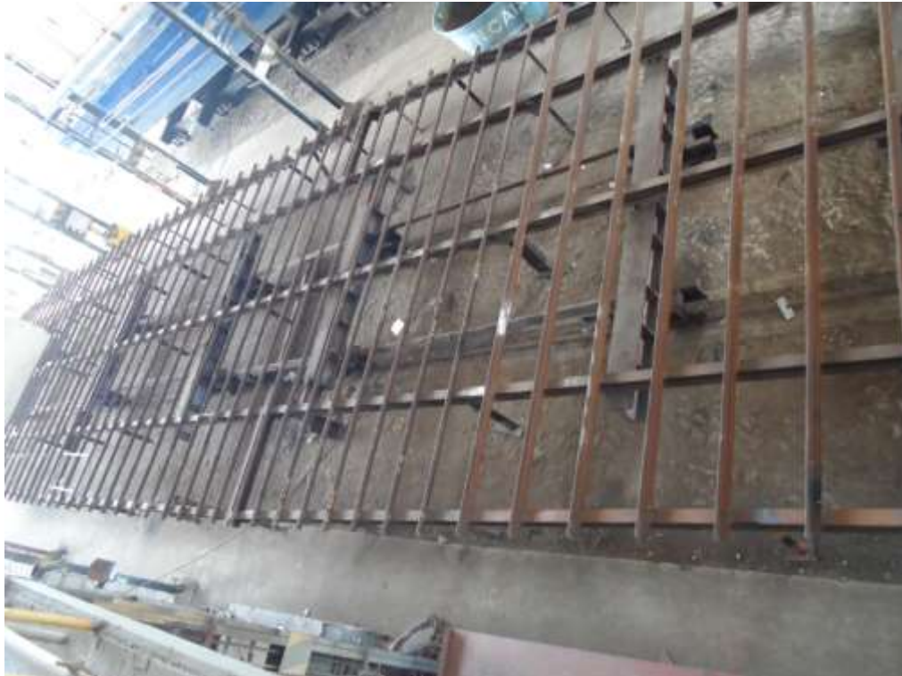
Foto 5 – Embarcação 654 com a estrutura do jig montado.
