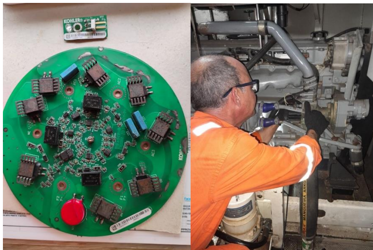
Figura 4. Retirada placas eletrônica do MCA BE para verificar possível falha de falta de geração de energia e troca de peças no MCA.
