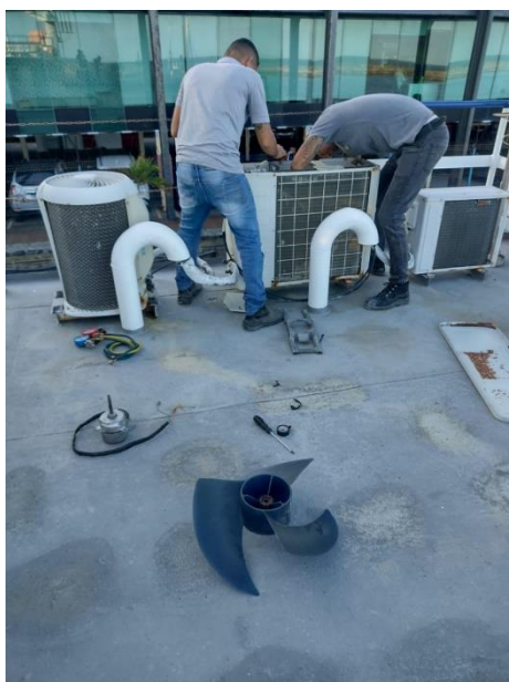
Figura 7. Serviço de manutenção dos aparelhos de ar-condicionado e instalações elétricas.
