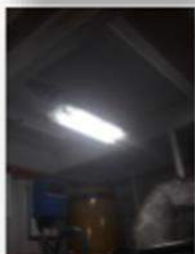
- Troca de iluminação para LED
