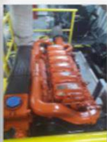
- Pintura dos motores MCA e MCP
