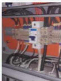
- Instalação de chave no quadro 24 wts
