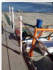
Reforço dos cabos do guarda corpo e pintura dos batentes
