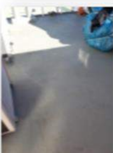
Pintura antiderrapante do piso
