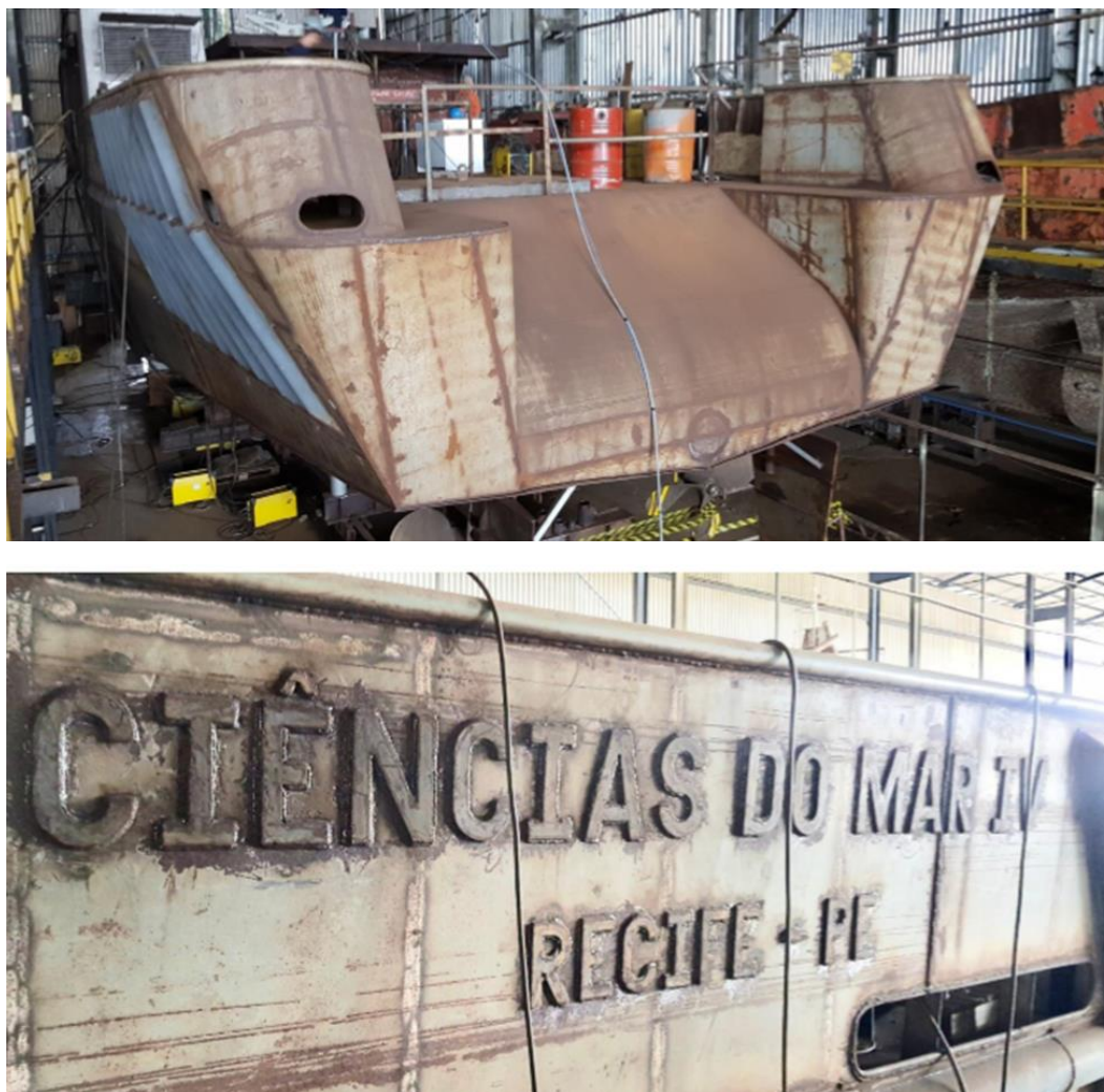
Figura 10: LEF Ciências do Mar IV em construção em Fortaleza/CE, nas dependências da INACE,
