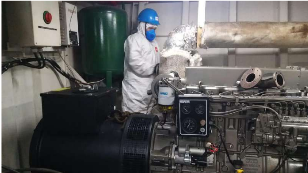
Figura 5f) Instalação dos dois geradores no NEP CM II.
