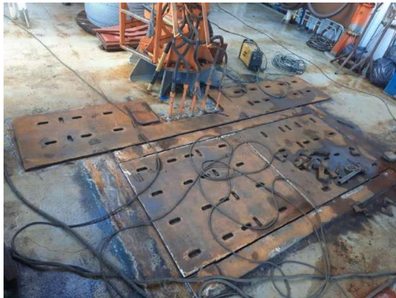
Figuras 3-c) Chapas de aço que foram fixadas no convés para receberem os guinchos de popa.
