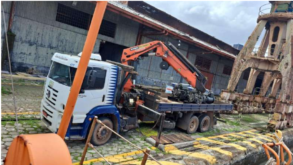
Figura 5a) Embarque dos dois geradores no NEP CM II.
