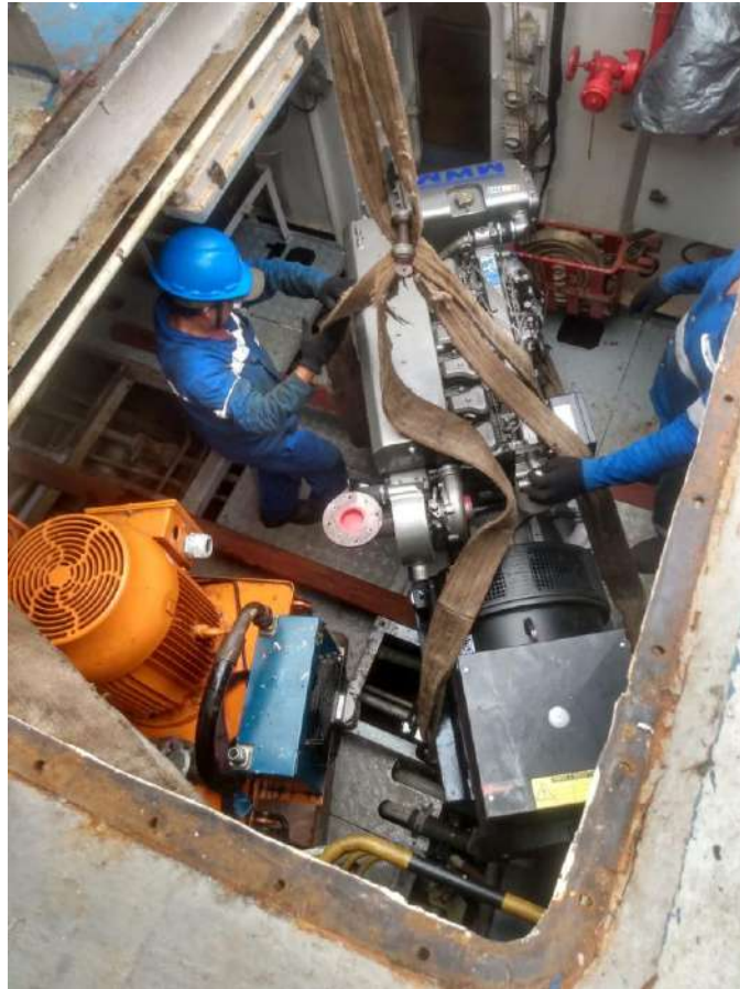
Figura 5d) Embarque e Instalação dos dois geradores no NEP CM II.
