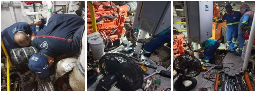
Figura 9. Serviço de reparo de motor pela empresa representante do fabricante do motor.
