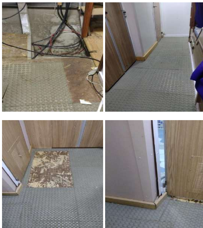
Figura 11. Reparo nos pisos dos camarotes.
