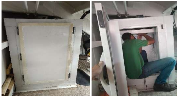
Figura 22. Conserto da câmara frigorífica.
