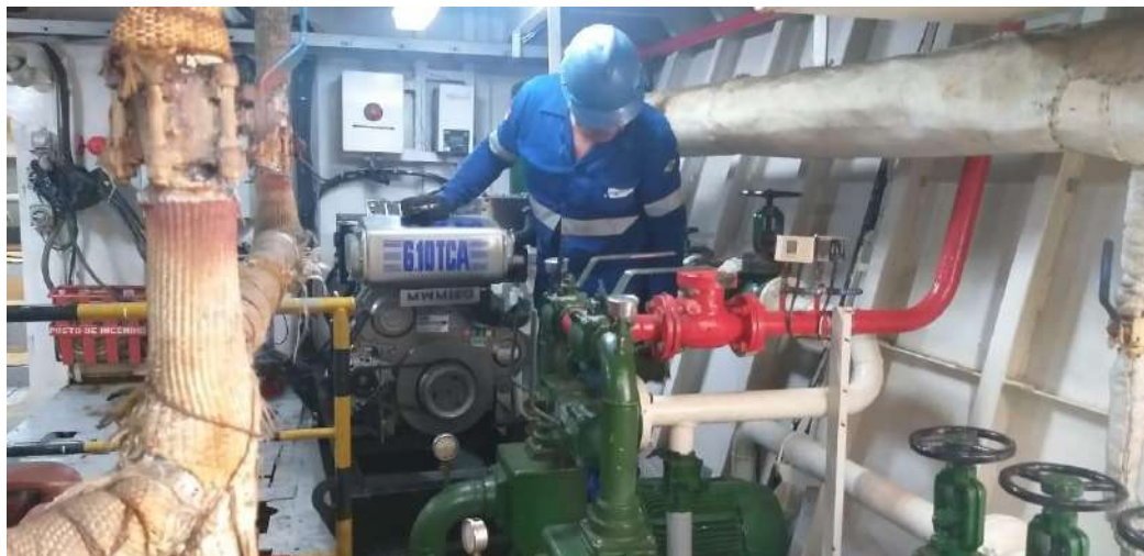
Figura 5e) Instalação dos dois geradores no NEP CM II.
