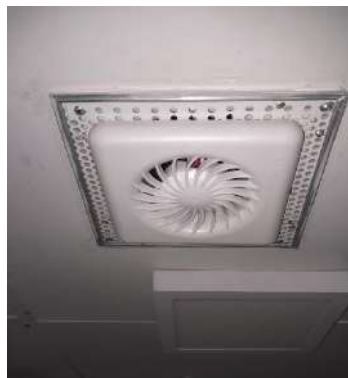
Figura 33. Instalação de exaustores nos banheiros.
