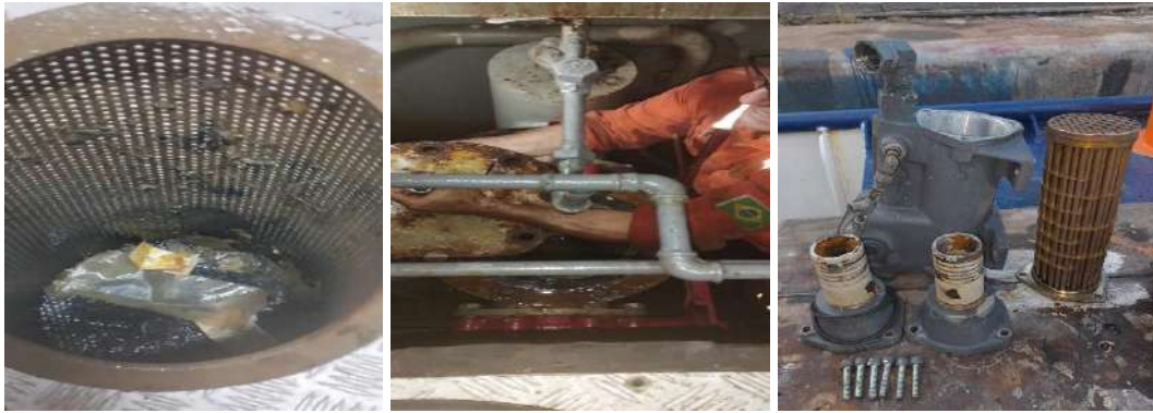
Figura 13. Limpeza dos trocadores de calor e das caixas de mar
