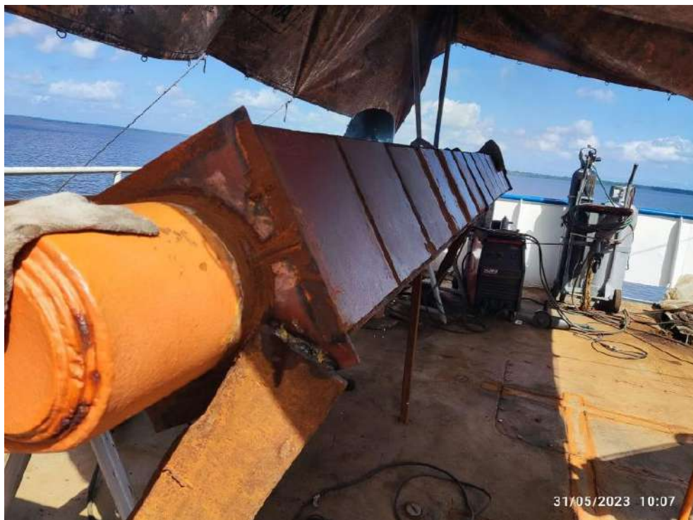
Figura 4c) Serviços de solda no A-frame quase concluídos.
