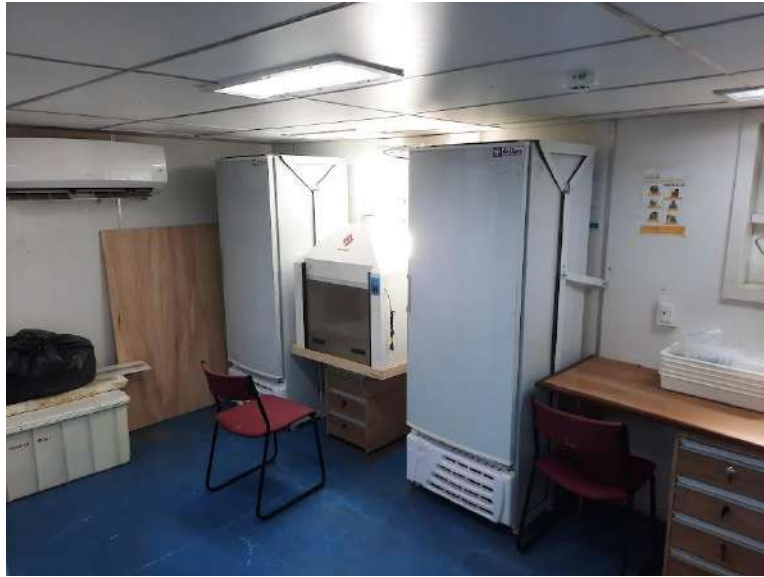
Figura 7) Capela de gases instalada no Laboratório Seco.
