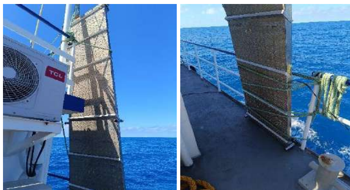
Figura 46. Serviço de fabricação de rampa de acesso.
